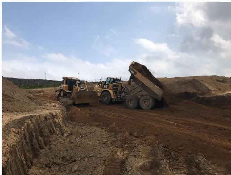
Figura 6.0. Depósito de material mediante la articulada 740B
