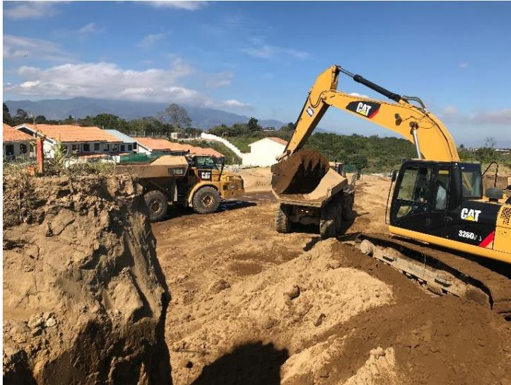
Figura 5.0 Cargado de Articuladas mediante retroexcavadora 326D
