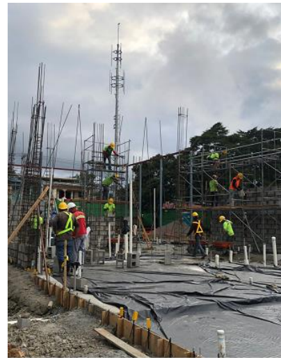
Figura 28. Estado del proyecto durante la primera visita. Fuente: Elaboración propia.
