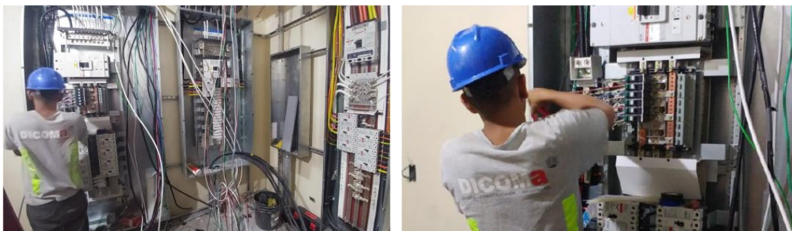
Figura 7. Proyectos de diseño y construcción electromecánico de DICOMA Construcción.
