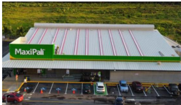
Figura 12. Maxi Palí Río Claro. Fuente: DICOMA Construcción.
