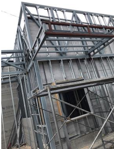
Figura 30. Estado del proyecto durante la tercera visita. Fuente: Elaboración propia.
