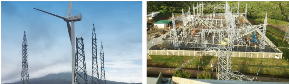
Figura 6. Proyectos de construcción de subestaciones eléctricas de DICOMA Construcción.
