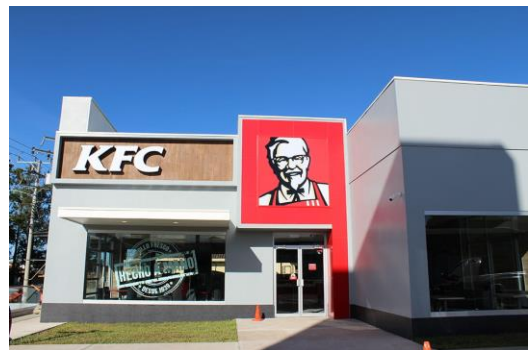
Figura 10. KFC San Francisco. Fuente: DICOMA Construcción.
