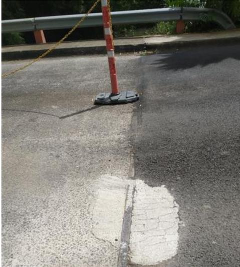
**Figura 1: Accesorios de un puente: Superficie de rodamiento, barandas y juntas de expansión**
