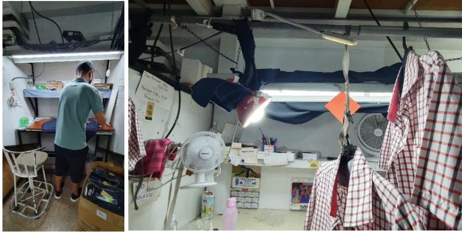
Figura 59. Ubicación de las luminarias de iluminación localizada en los puestos de inspección.
