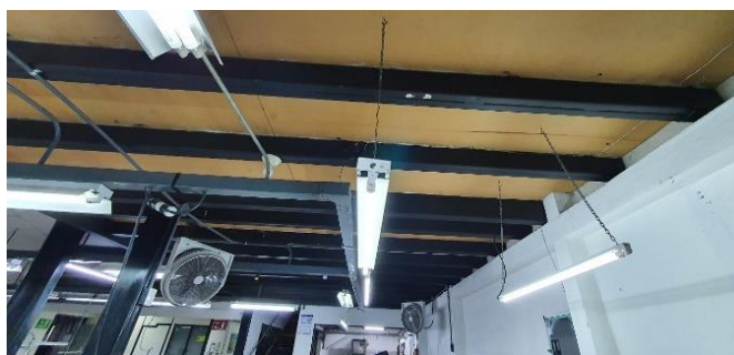
Figura 58. Cielorraso de las áreas de la fusionadora y planchado color café.
