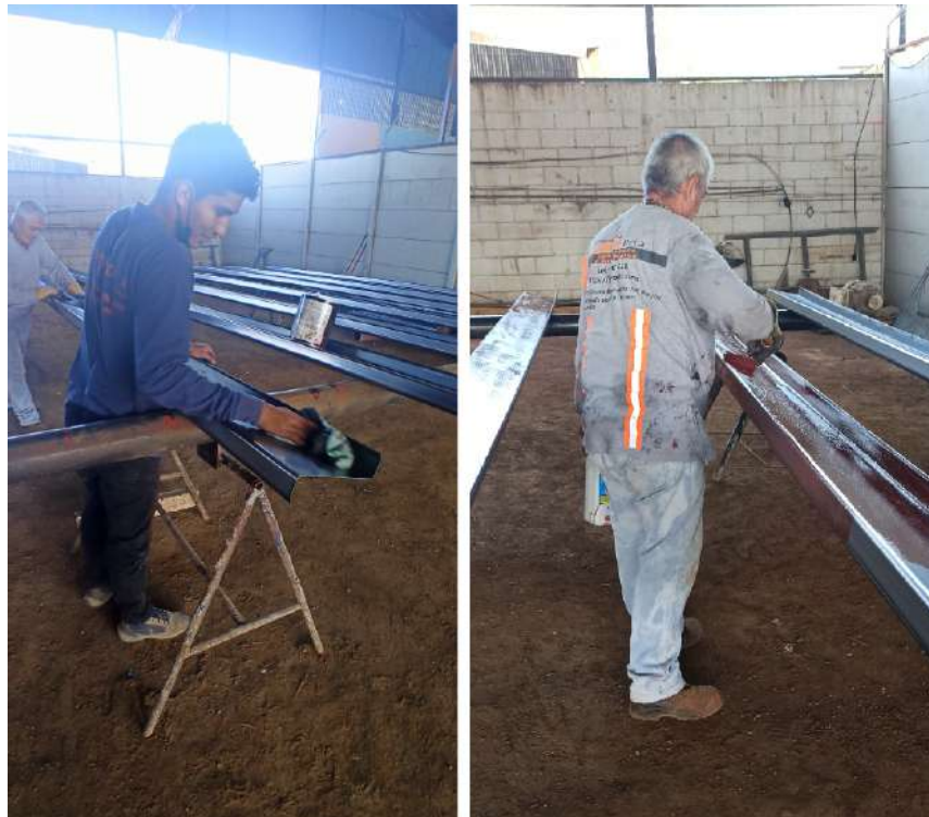
Figura 31. Limpieza y aplicación de pintura de clavadores tipo Z. Fuente: Autoría propia.
