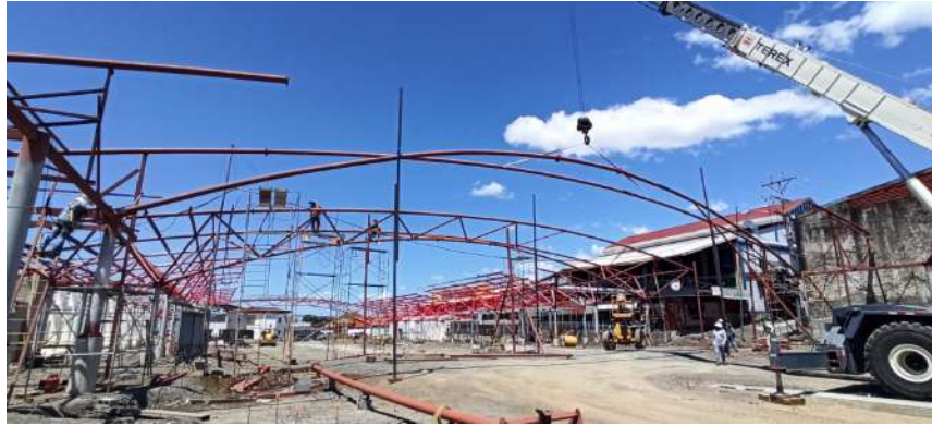
(c) Montaje de arco del andén 2. Fuente: Autoría propia.
