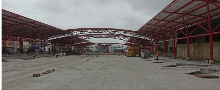
(g) Culminación de la construcción estructural del proyecto terminal de buses de Alajuela FECOSA Fuente: Autoría propia.
