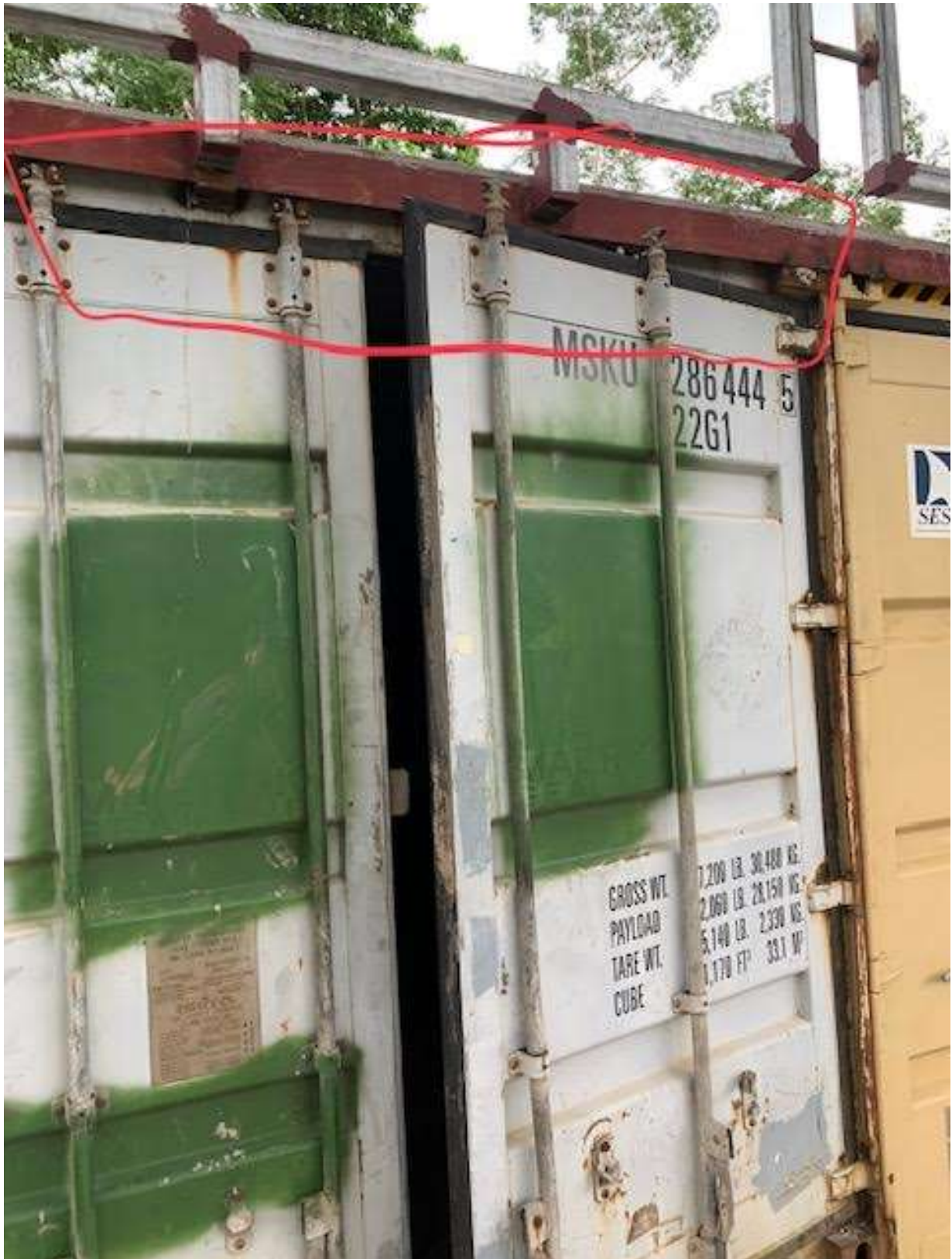
(c) Contenedores para almacenaje con problemas de cierre. Fuente: Grupo Constructora JDD Ltda.
