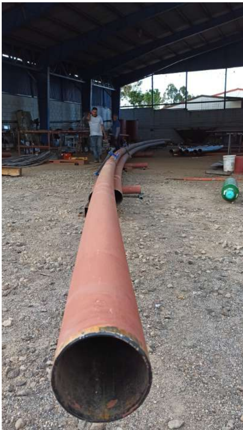
(i) Proceso de armado de curva para arco del andén 1. Fuente: Autoría propia.
