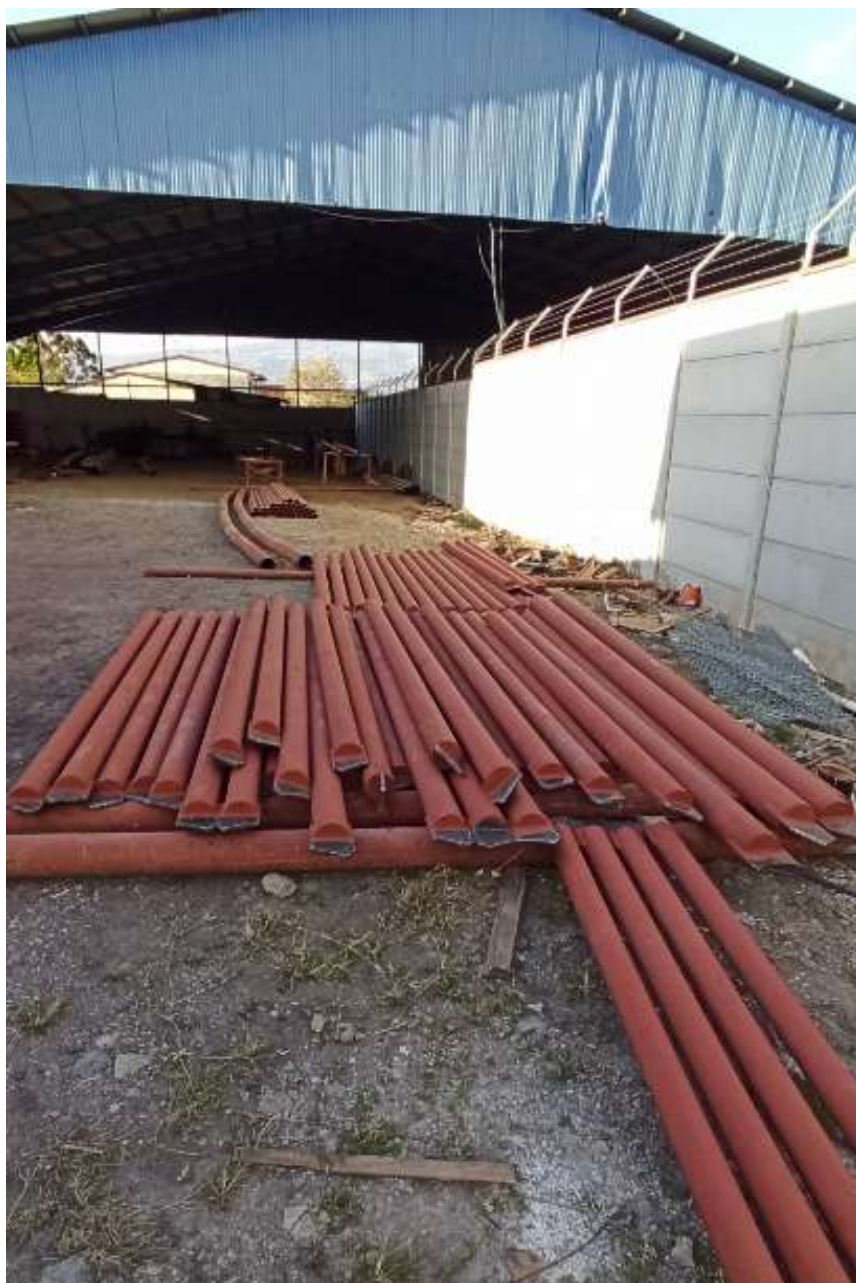
(j) Almacenamiento de material preparado para llevar a sitio. Fuente: Autoría propia.
