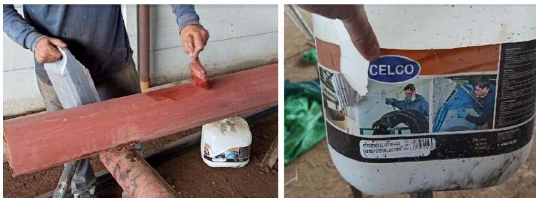
Figura 24. Aplicación de removedor de pintura y producto utilizado.
