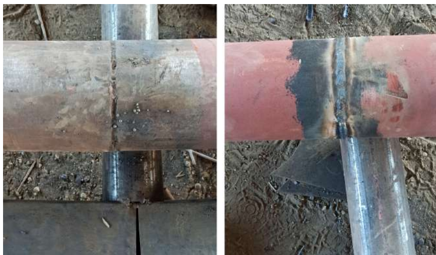
Figura 26. Fondeo y resoldado del empalme de tubos de hierro. Fuente: Autoría propia.
