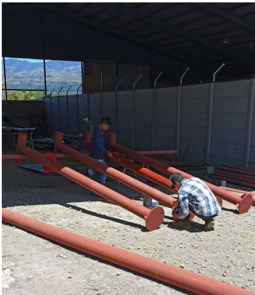
(h) Aplicación de pintura a pedestales o columnas de estructura de techo. Fuente: Autoría propia.
