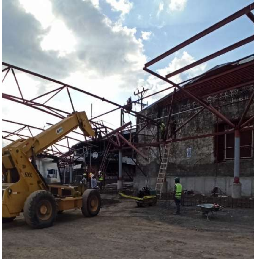
(e) Montaje de diagonales de techo en andén 2 Fuente: Autoría propia.
