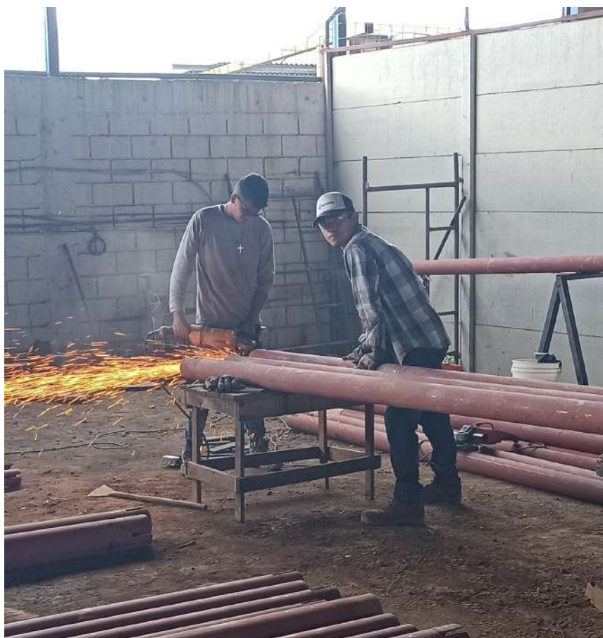
Figura 25. Corte de tubo de hierro estructural con esmeril. Fuente: Autoría propia.
