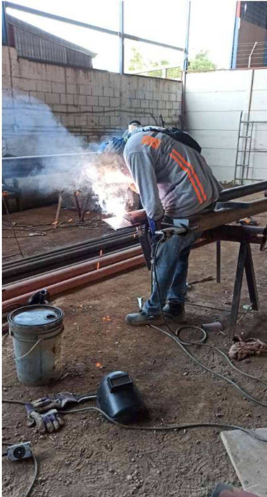
(e) Proceso de soldadura de placas y tapas a tubo de hierro. Fuente: Autoría propia.
