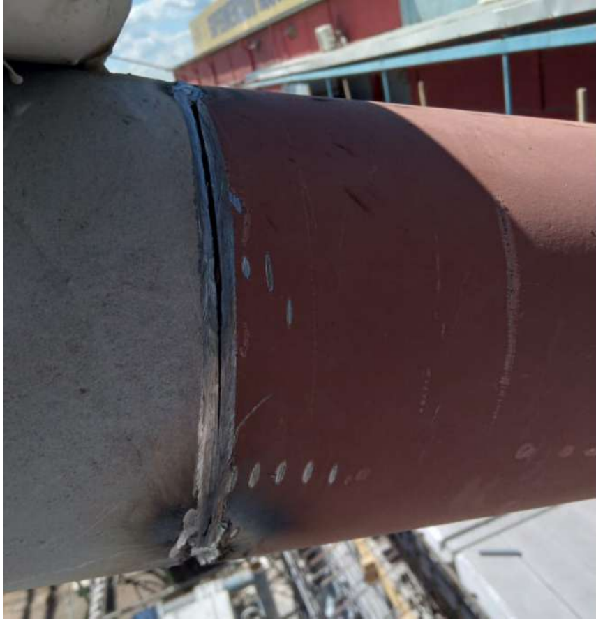
(d) Elementos unidos únicamente con puntos de soldadura. Fuente: CONICO, 2022.
