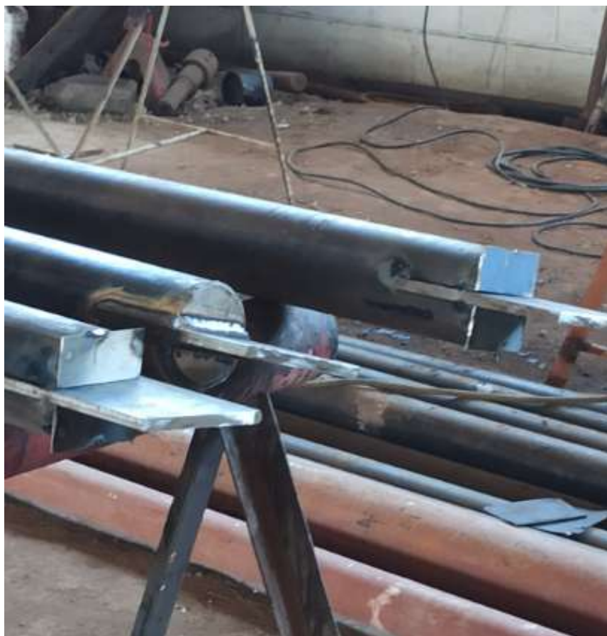
(d) Colocación de placas y tapas a tubo de hierro previo a la soldadura de estas. Fuente: Autoría propia.
