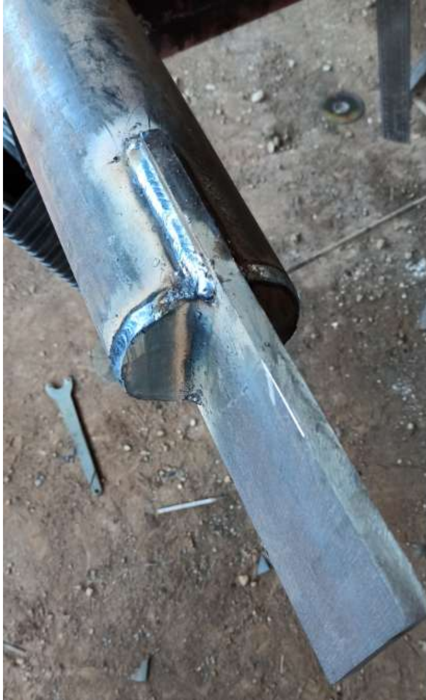
(f) Producto de la soldadura de placas y tapas a tubo de hierro. Fuente: Autoría propia.
