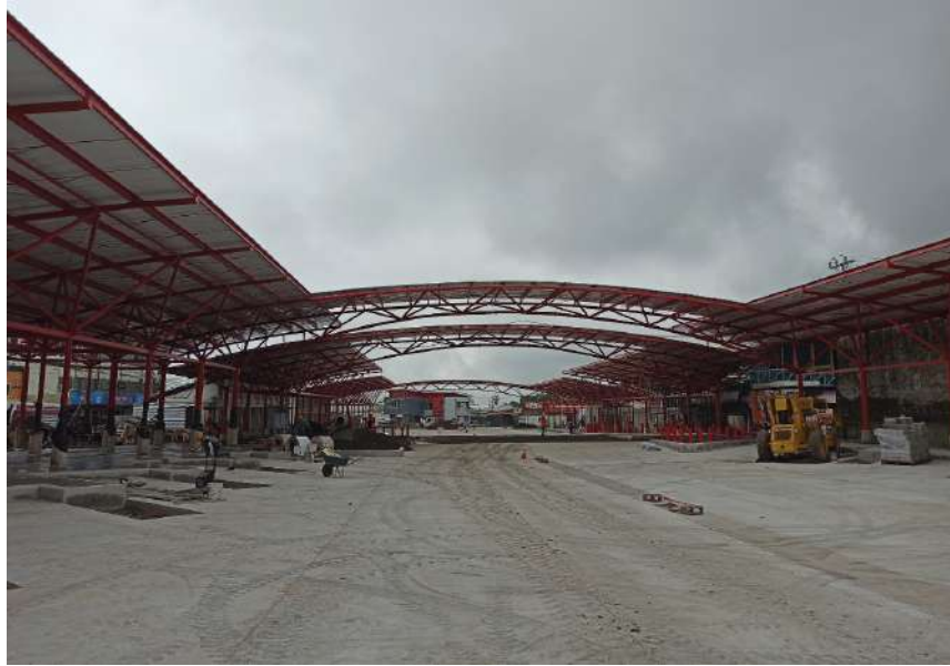
Figura 1. Vista general de proyecto Terminal de buses de Alajuela FECOSA terminado desde el andén 2
