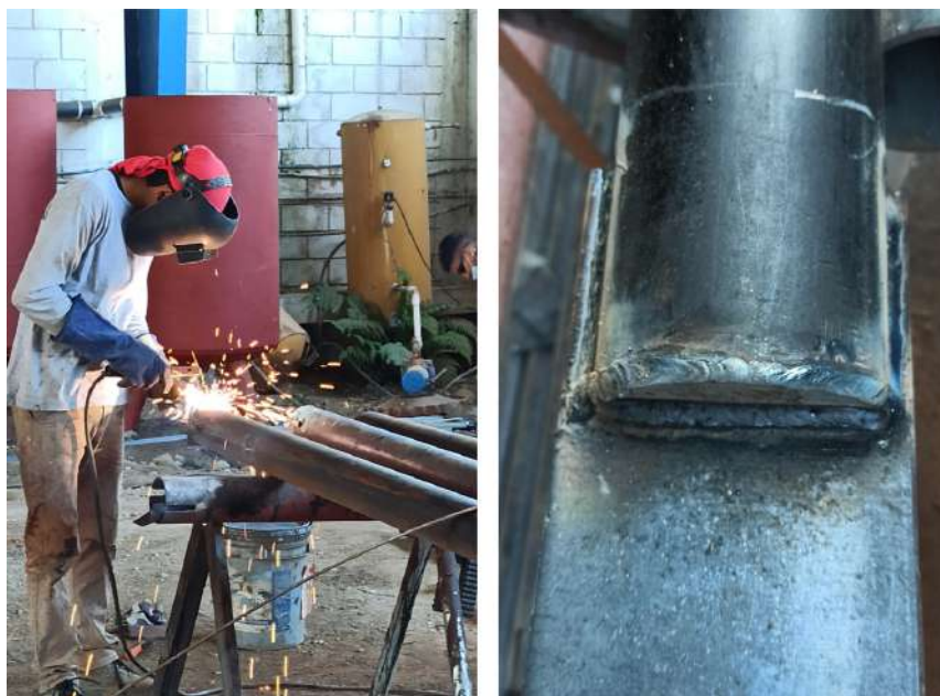
Figura 28. Soldadura de placas y tapas a tubo de hierro.
