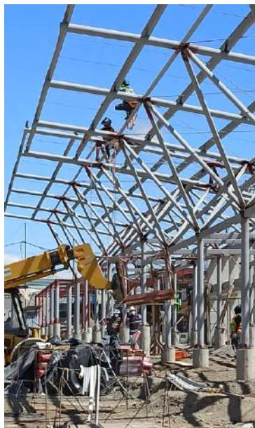
(b) Instalación de tubos de amarre de techo en andén 2. Fuente: Autoría propia.
