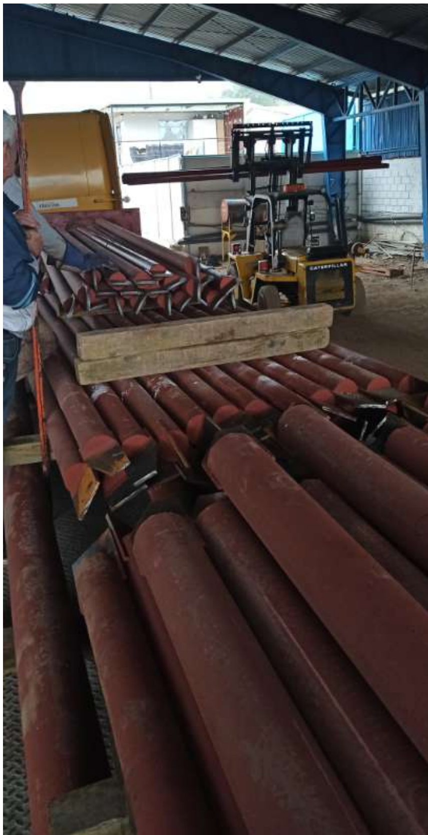
(k) Carga de material preparado a remolque con montacarga para transporte a sitio. Fuente: Autoría propia.
