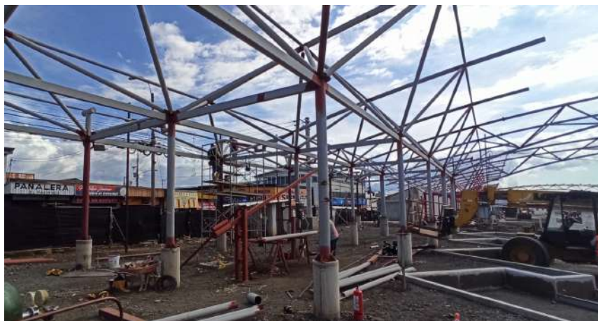
(f) Resoldado de uniones en andén 2 Fuente: Autoría propia.
