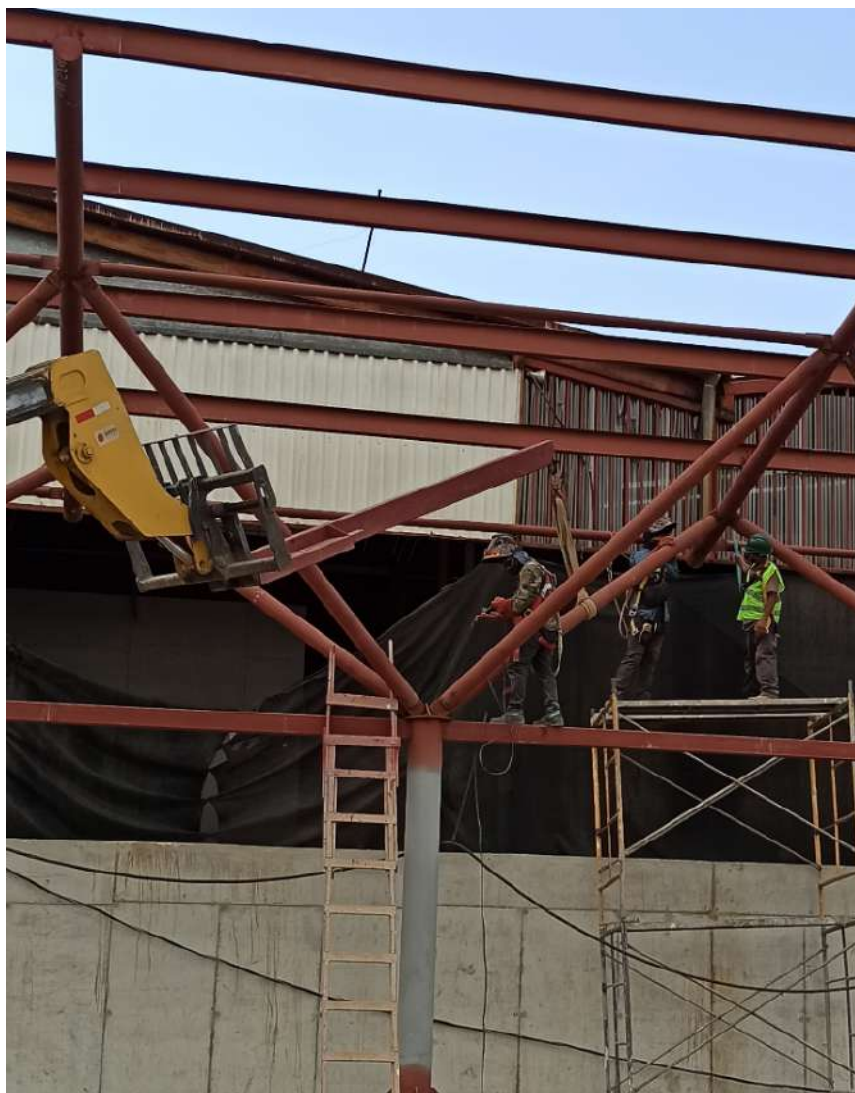
Figura 30. Montaje de diagonal en la estructura de techo del andén 2. Fuente: Autoría propia.
