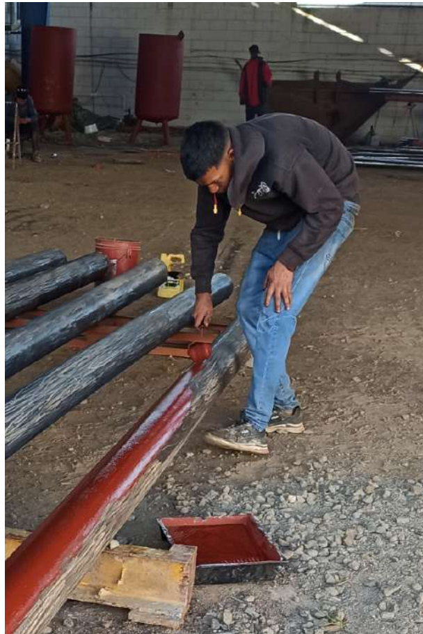
Figura 29. Aplicación de pintura minio con rodillo a tubos de hierro. Fuente: Autoría propia.
