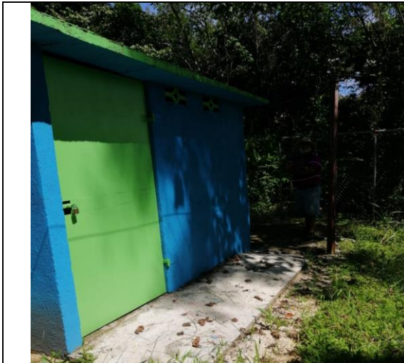
Foto 1. Casetilla donde se ubica la bomba.
