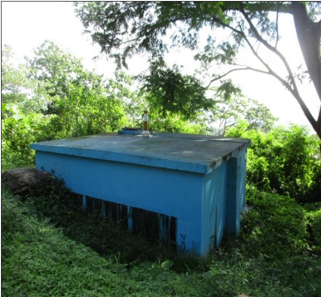
Foto 1. Tanque la plaza, se puede apreciar la pintura, el clorador en la parte superior, y la piedra que se utiliza como escalera externa.
