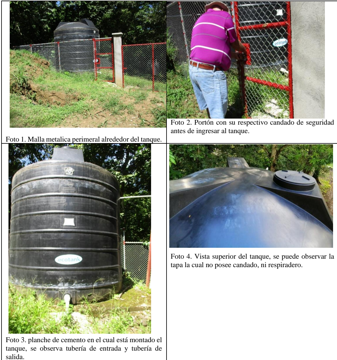
Figura 5.12 Fotos del tanque el Buey Negro. Fuente: Elaboración propia
