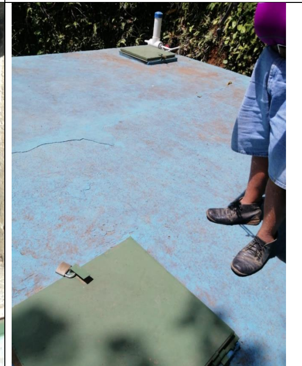
Foto 4. Parte superior del tanque los Abarca, se pueden observar ambas tapas con su respectivo candado.
