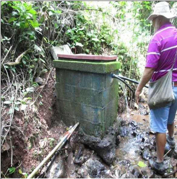
Foto 1. Tanque de reunión abarca. Se observa la entrada y salida de caudales.
