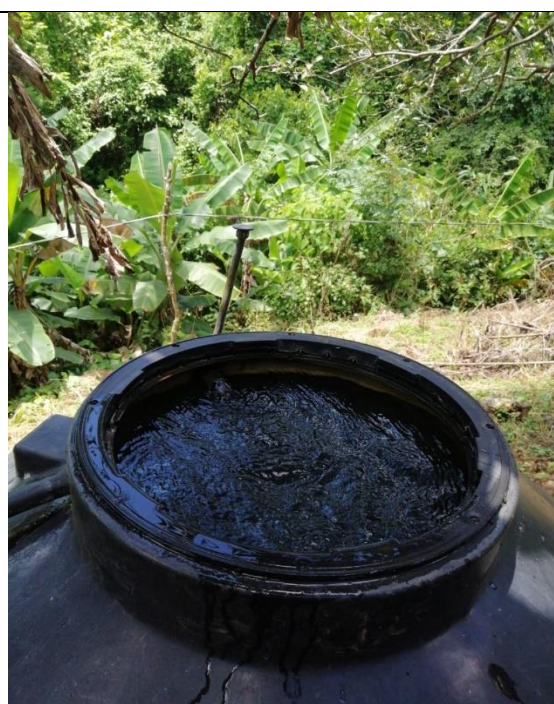
Foto 2. Vista superior del tanque, se puede observar la tapa y el nivel de agua.
