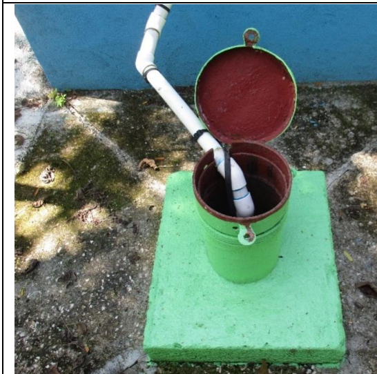
Foto 3. salida del tubo desde lo hondo del pozo.
