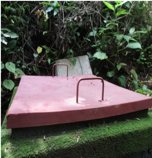
Foto 3. Tapa del tanque reunión abarca, aún no posee candado o sistema de seguridad.
