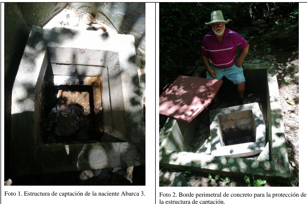
Figura 5.6 Fotos de la estructura de captación de la naciente Abarca 3. Fuente: elaboración propia.
