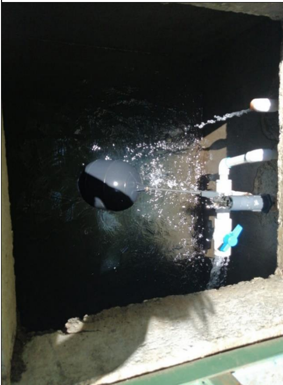
Foto 3. Entrada del caudal al tanque los Abarca.
