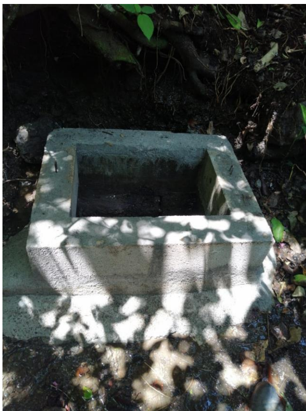
Figura 5.4 Foto de la estructura de captación de la naciente Abarca 1. Fuente: elaboración propia.
