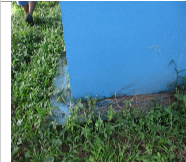
Foto 3. Acera perimetral existente actualmente.
