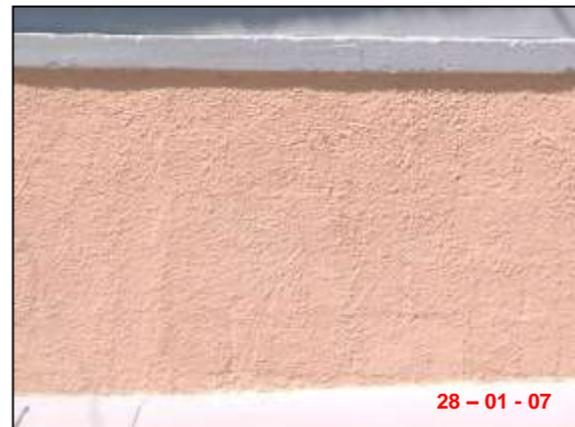
Muro exterior de la vivienda, hecho por medio de un repello pringado de concreto
