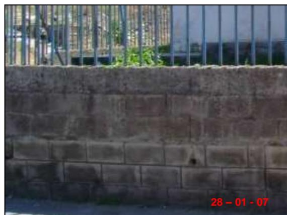
Block de concreto utilizado como muro, el mismo deja ver la textura natural del block ya que no tiene ningún recubrimiento o repello
