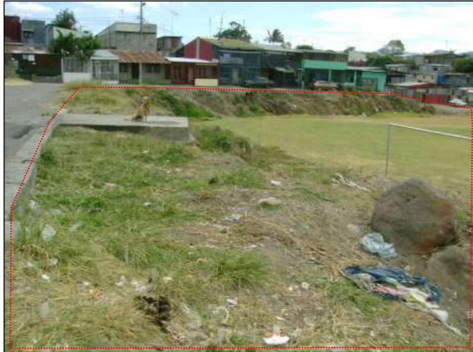
Condición actual presente en la Cancha de Fútbol de la Urbanización, actualmente la Calle localizada en la Alameda 2 de la localidad, presenta desprendimientos de terreno por la ausencia de un muro de contención en sitio
