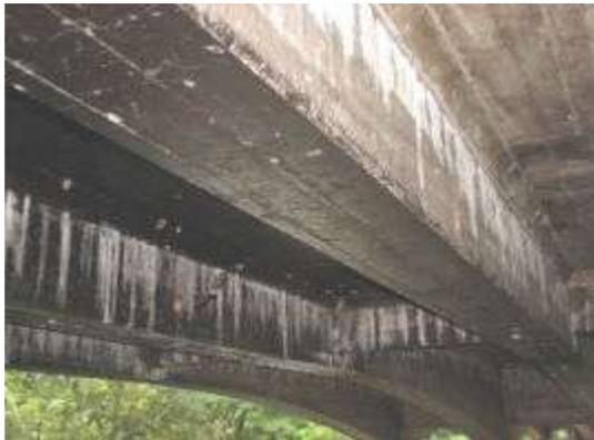
Figura 27. Eflorescencia en vigas
