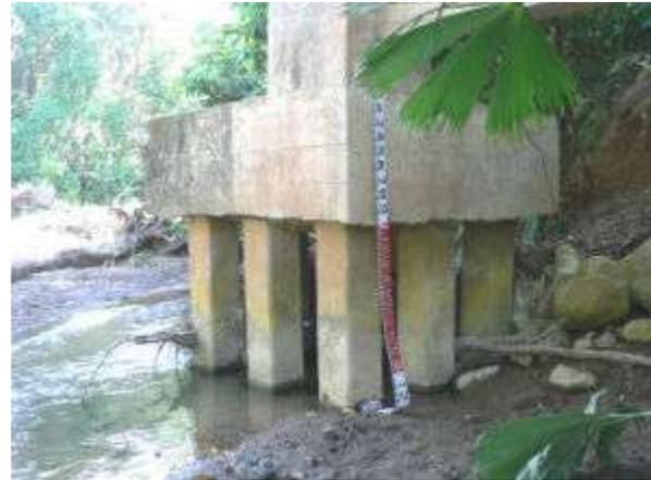
Figura 28. Socavación en la fundación
