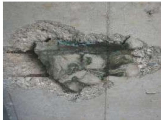
Figura 26. Nidos de piedra en losa de concreto
