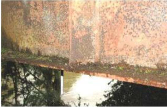
Figura 24. Oxidación en viga principal
