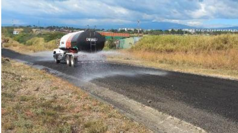
*Figura 4-21 Aplicación de humedad al material previo a la dosificación de emulsión asfáltica*
