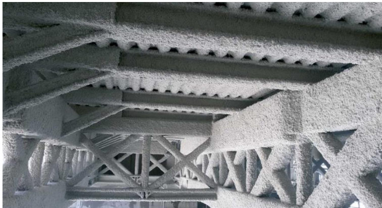
Figura 38. Ejemplo de la aplicación de mortero ignífugo (Mercor Tecresa).
