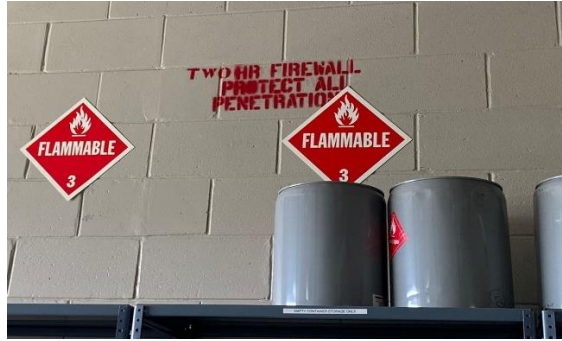
Figura 23. Pared con resistencias al fuego por 2 horas del centro de almacenamiento de UCF (Foto tomada por los autores).
