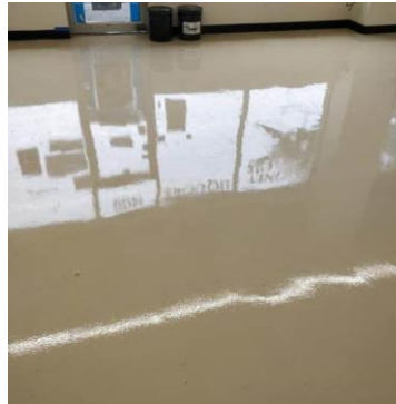
Figura 28. Piso epóxico para el centro de almacenamiento de residuos químicos del TEC. (Exterior Coating)
