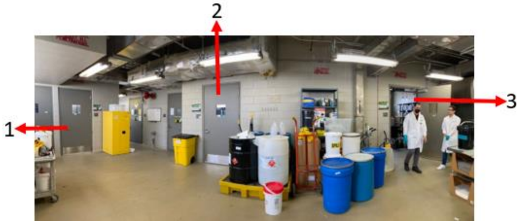
Figura 20. Interior del Centro de Almacenamiento de residuos químicos de UCF. Habitación 1: sustancias ácidas, Habitación 2: sustancias básicas y no reguladas y Habitación 3: sustancias inflamables (Foto tomada por los autores).
