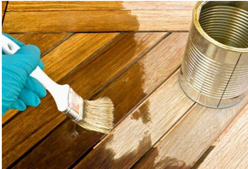
Figura 1. Preservación de madera con el uso de brocha. (Fuente Madera 21, 2020).
