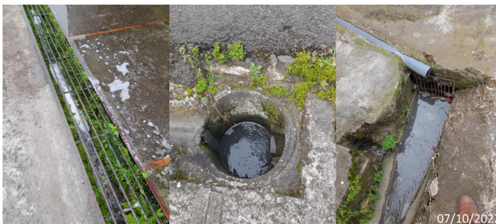
Figura 5.6. Vertido de aguas grises o jabonosas en las cunetas de la vía pública en el cuadrante urbano de Paraíso
