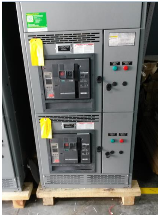
Figura 6.3. Montaje de los interruptores termomagnéticos en gabinetes. (Fabián Blanco Piña, 2015)
