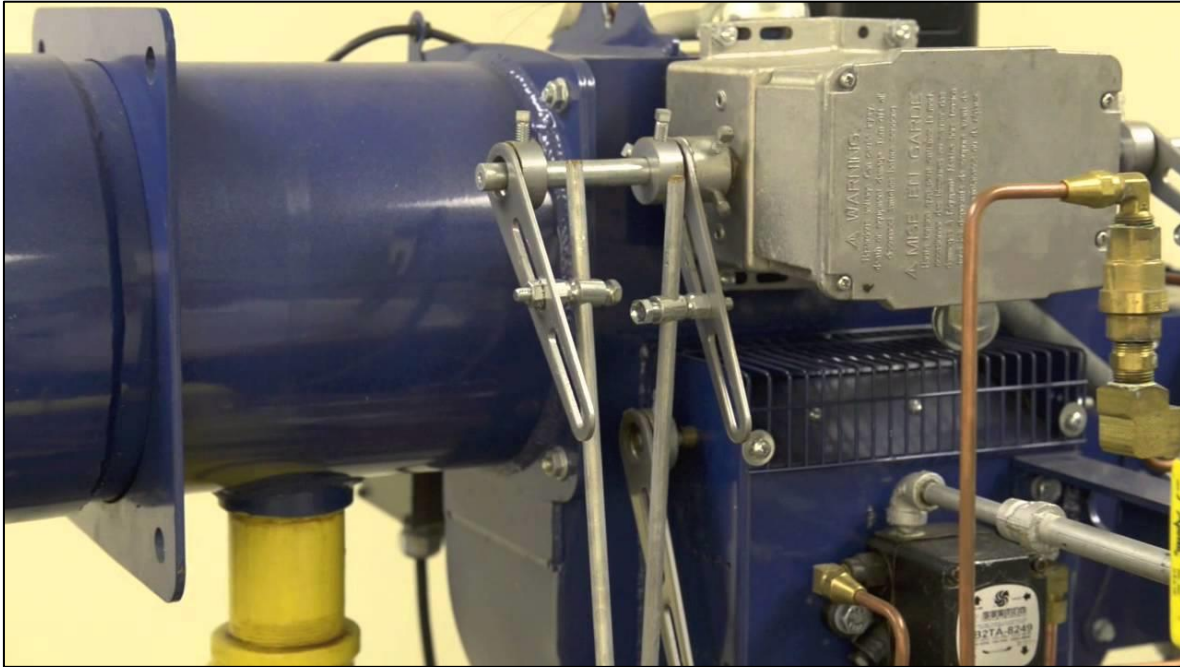
Figura 2. 29. Sistema de varillaje de una caldera. (Tomado de https://www.youtube.com/watch?v=Md6irOOEB2k )
