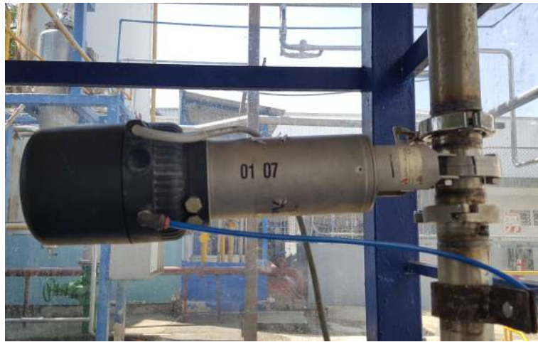
Figura 3.6: Detalle del resultado de la unión de la válvula para el agua. Fuente: Elaboración propia
