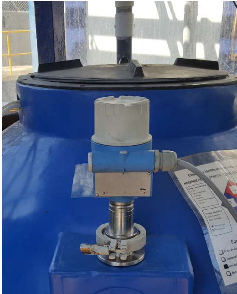
Figura 3.10: Unión final de la sonda con el tanque de mezcla. Fuente: Elaboración propia
