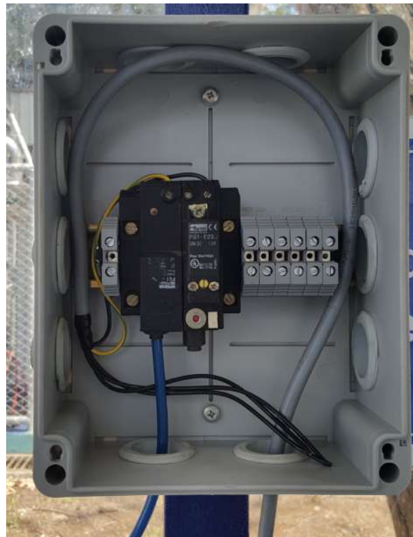
Figura 3.7: Electroválvula para el control de la bomba neumática. Fuente:Elaboración propia
