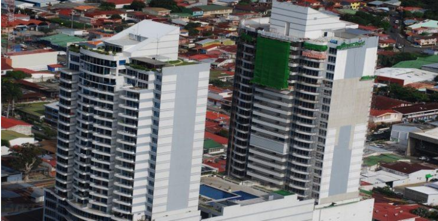
Fig.6. Imagen ilustrativa de un edificio de apartamentos de Costa Rica. Tomada de internet [d]
