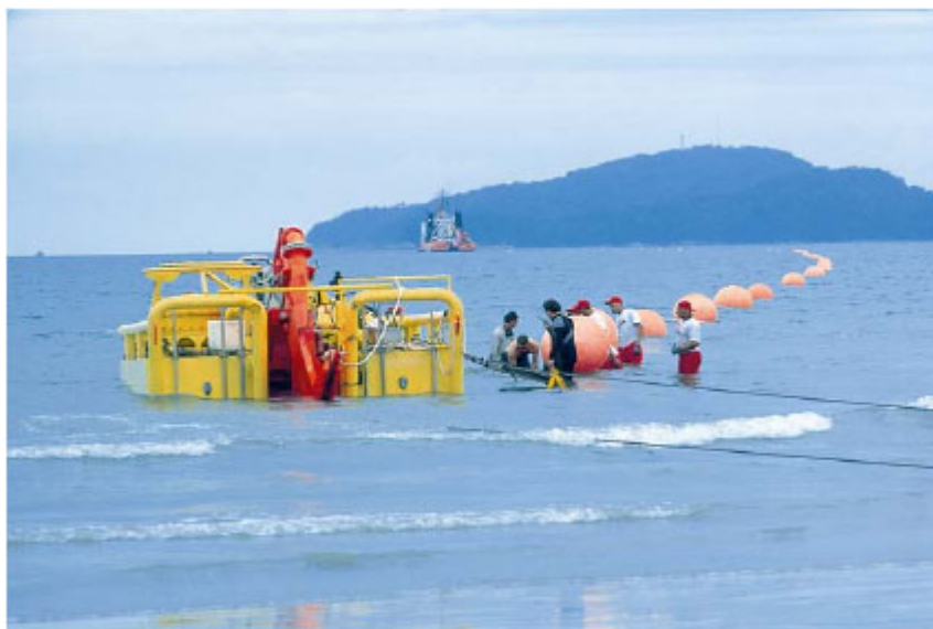
Figura 8.8 Arado a punto de iniciar el enterrado del cable
