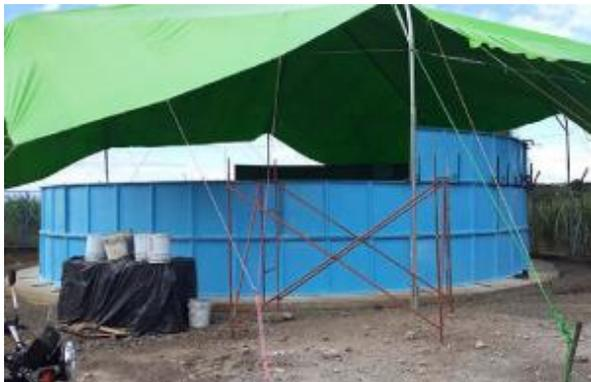
**Figura 20.** Colocación de los paneles de fibra de vidrio.
