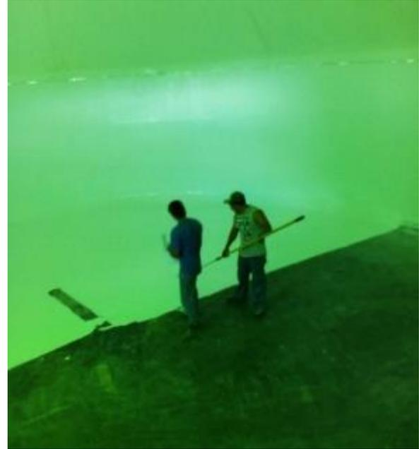
**Figura 21.** Aplicación del impermeabilizante Gelcoat.
