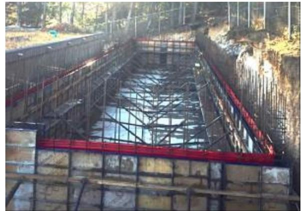
**Figura 9.** Encofrado para colado de muros.
