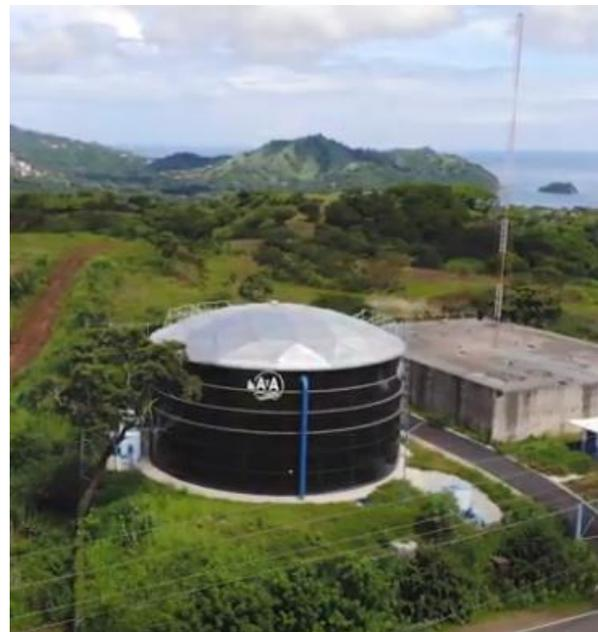
**Figura 2.** Tanque de acero vitrificado en Playas del Coco.
