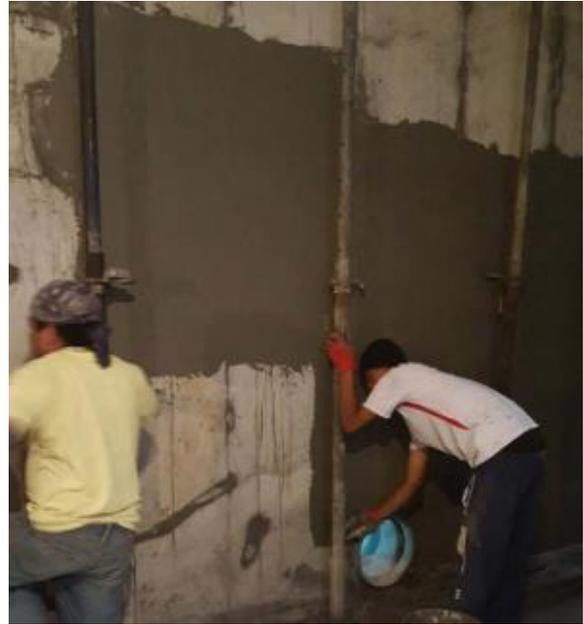
**Figura 11.** Impermeabilización de muros.
