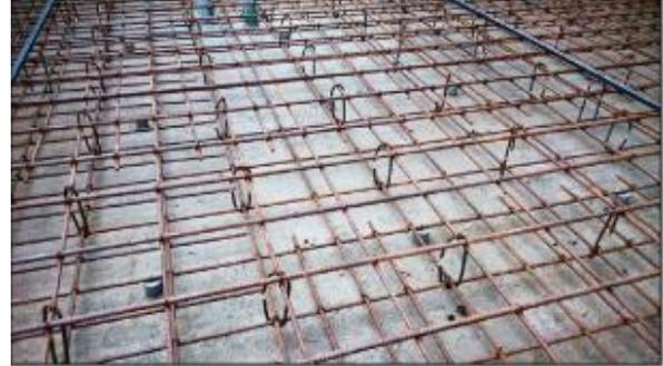
**Figura 6.** Armadura de refuerzo en losa de cimentación.
