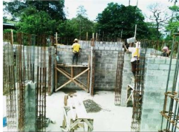
**Figura 14.** Colocación de muros de mampostería.
