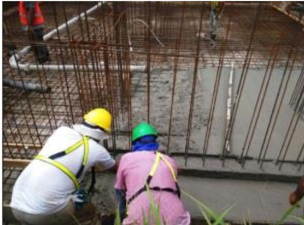
**Figura 13.** Colado de cimentación en tanque de mampostería.
