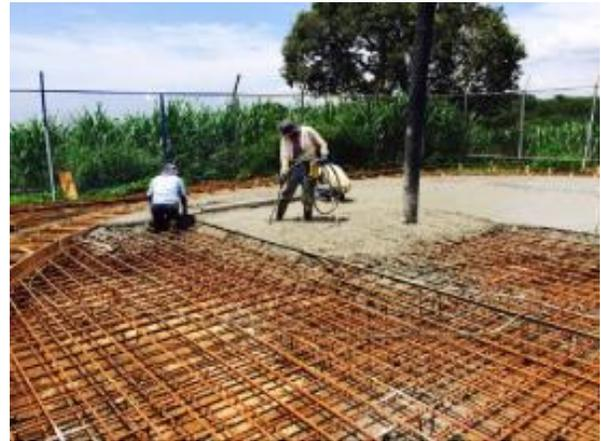
**Figura 18.** Colado de losa circular.
