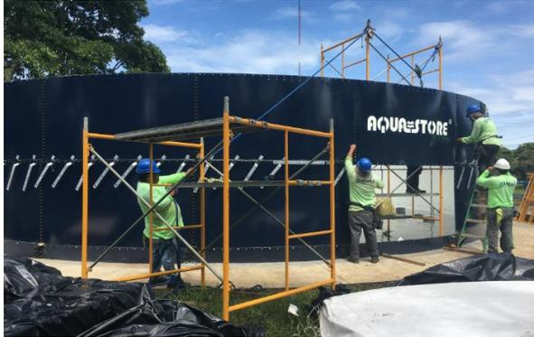
**Figura 26.** Colocación de los paneles de acero vitrificado.
