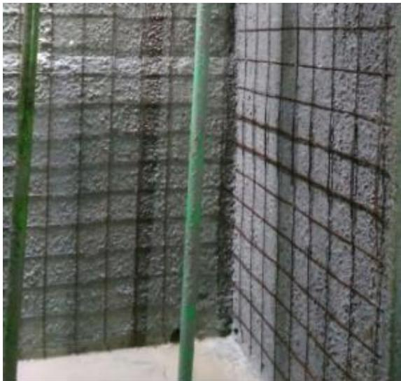
**Figura 16.** Impermeabilización interna de los muros.
