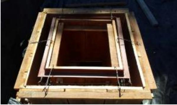
**Figura 15.** Encofrado del acceso al tanque en la losa de techo.
