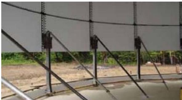
**Figura 27.** Colocación de paneles con gatas.
