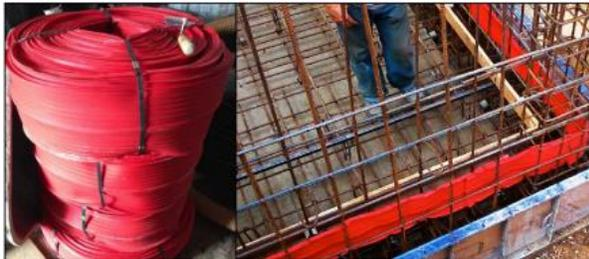
**Figura 8.** A la izquierda cinta de PVC impermeable (waterstop) antes de ser colocada y a la derecha waterstop colocado.
