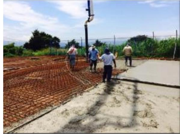
**Figura 25.** Colado de la losa de cimentación. Fuente: Chaves, 2016.
