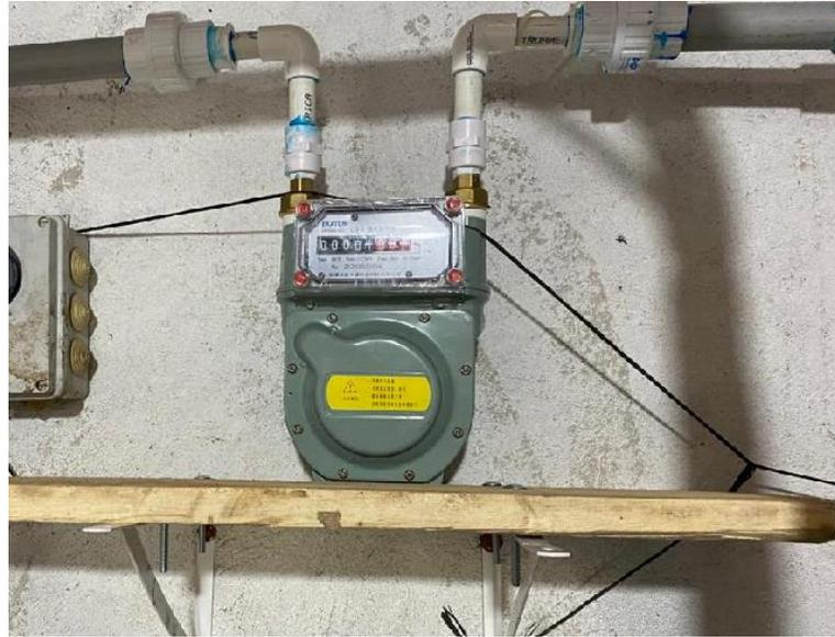
**Figura 2** Equipo para medición de flujo del biogás.
