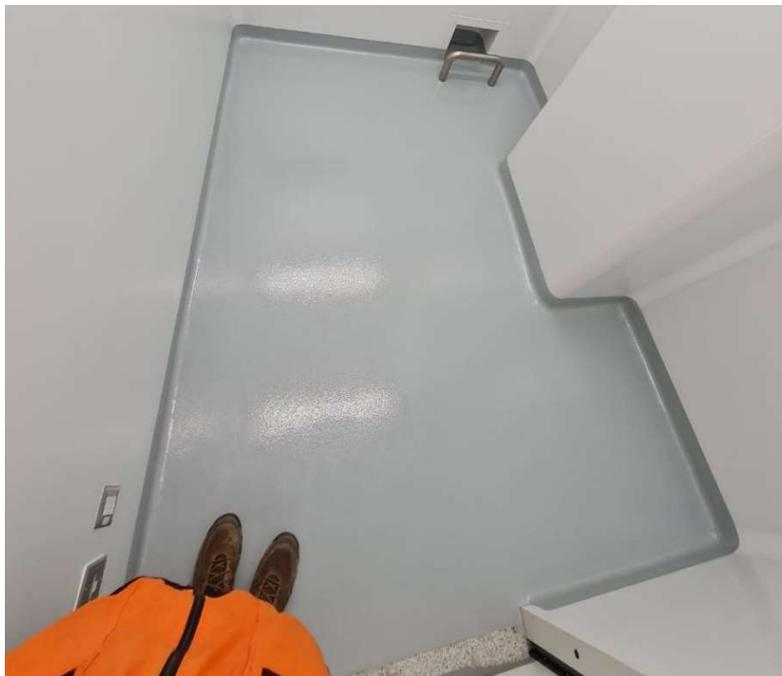
**Figura 17:** Fotografía de piso epóxico gris con acabado de piel de naranja
