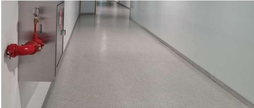
**Figura 16:** Fotografía de piso epóxico gris
