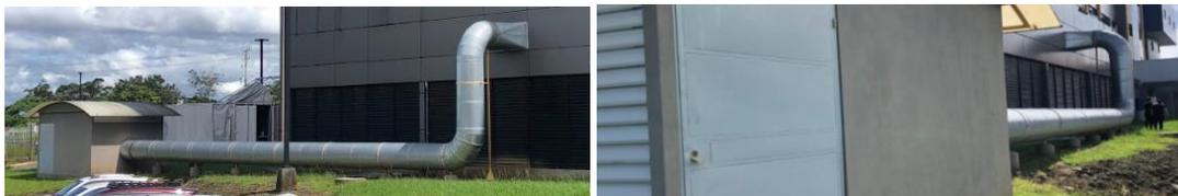
**Figura 5.4.** Pérdidas por fricción y distancia del ducto de extracción principal.
