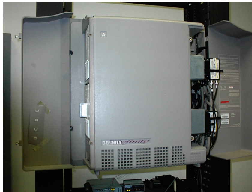
Figura 4.9 Central telefónica Lucent Definity
