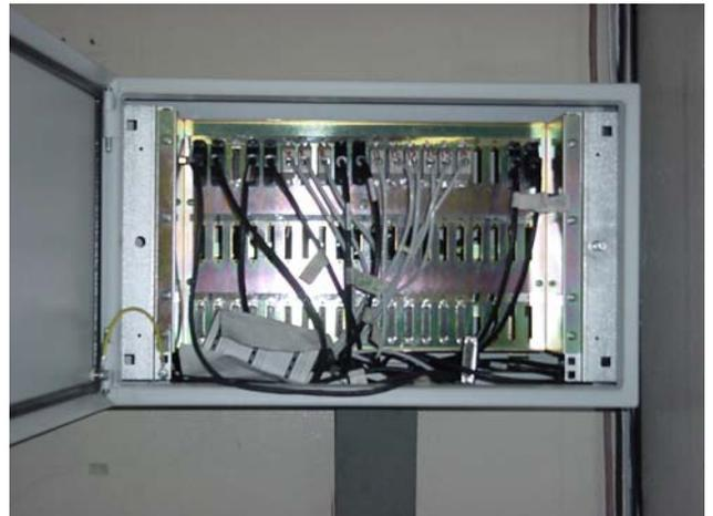
**Figura 7.8.** Cada uno de las centrales está conectado al frontal por medio de una tarjeta multipuerto, en esta figura se aprecia como se concentran las líneas de información desde las centrales y que van luego hacia el frontal.
