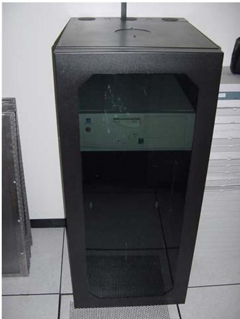
**Figura 7.6.** Armario que protege y contiene el frontal que supervisa las centrales de las figuras 7.5 y 7.6.
