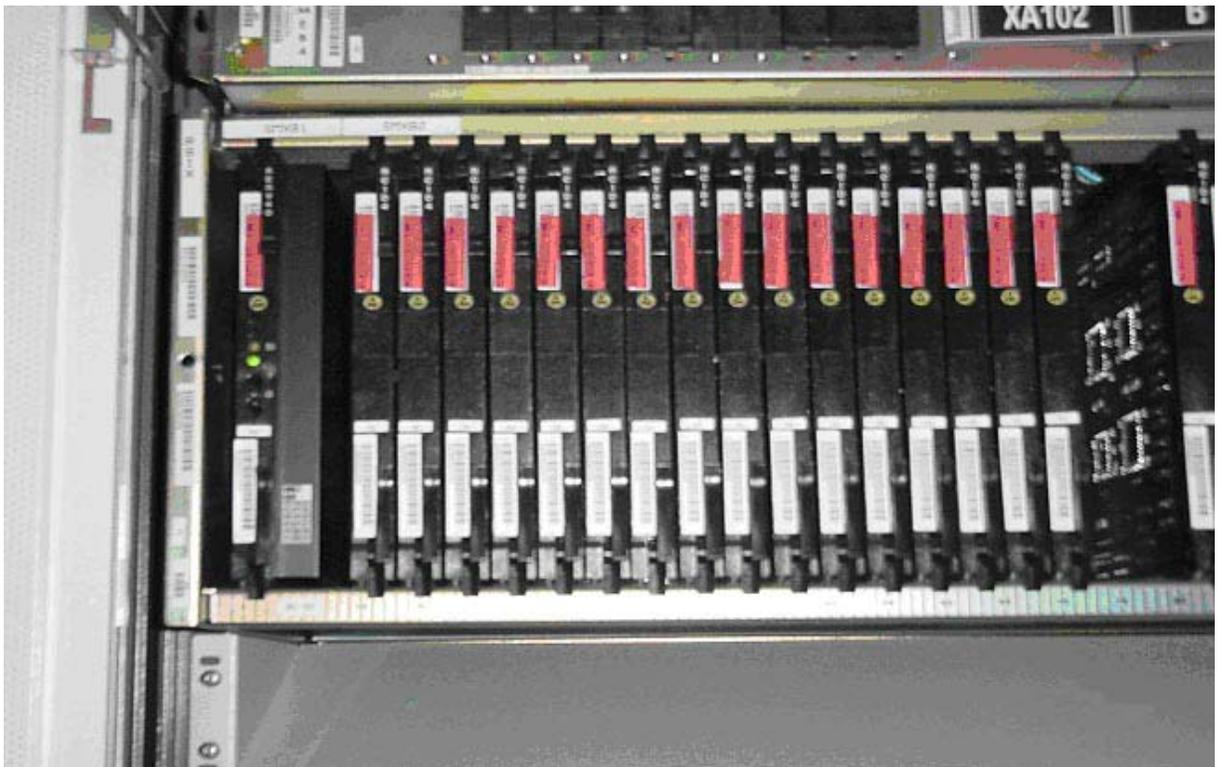
**Figura 7.4.** Vista interior de una central telefónica marca Alcatel, se pueden apreciar las tarjetas de conmutación.
