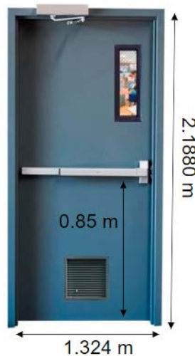
Figura 9. Puerta cortafuego para bodega de almacenamiento de sustancias inflamables y combustibles.
