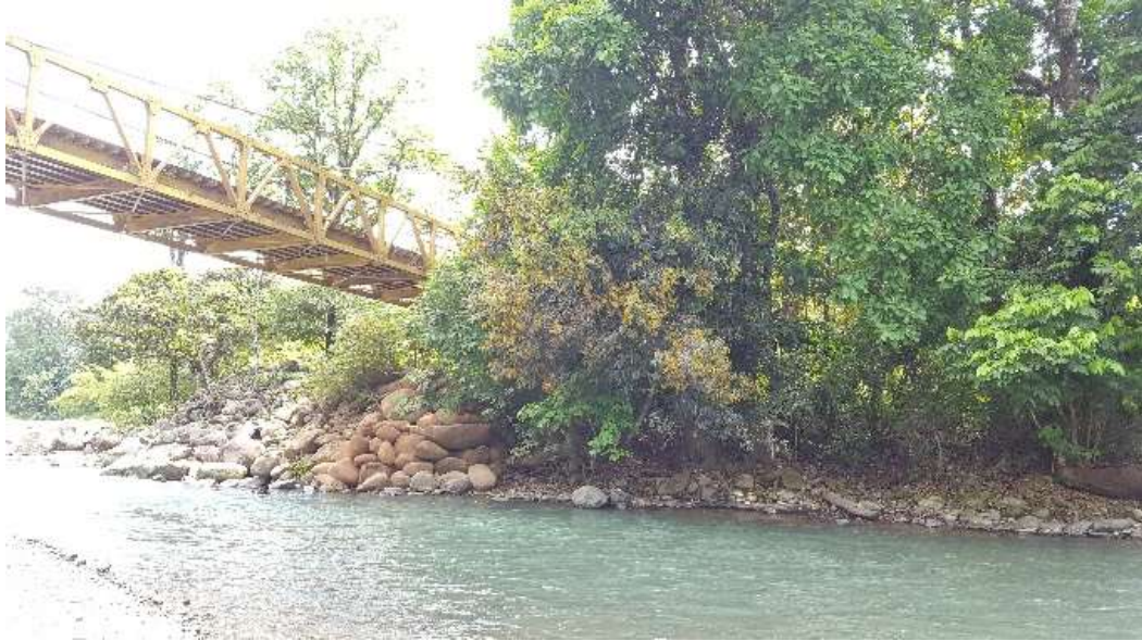
Fin de puente existente
