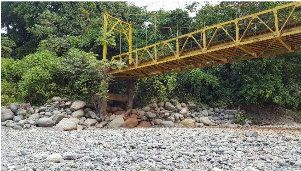
Inicio de puente existente.
