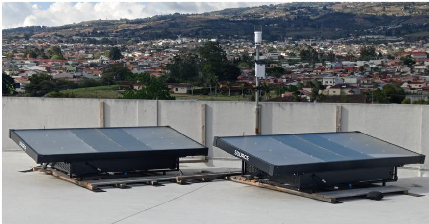
**Figura 2.6:** Hidropaneles ubicados en la Escuela de Ingeniería Electrónica en Cartago. [18]
