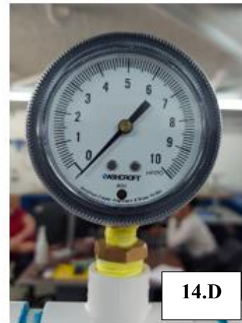
Figura 14. Cambio de manómetros de entrada y salida del filtro de 15 inH 2 O a 10 inH 2 O.
