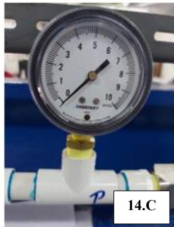
Figura 14. Cambio de manómetros de entrada y salida del filtro de 15 inH 2 O a 10 inH 2 O.
