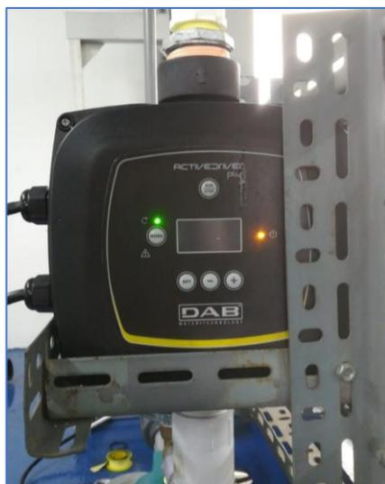
**Figura 17.** Inverter o variador de frecuencia DAB Active Driver Plus. Elaboración propia.
