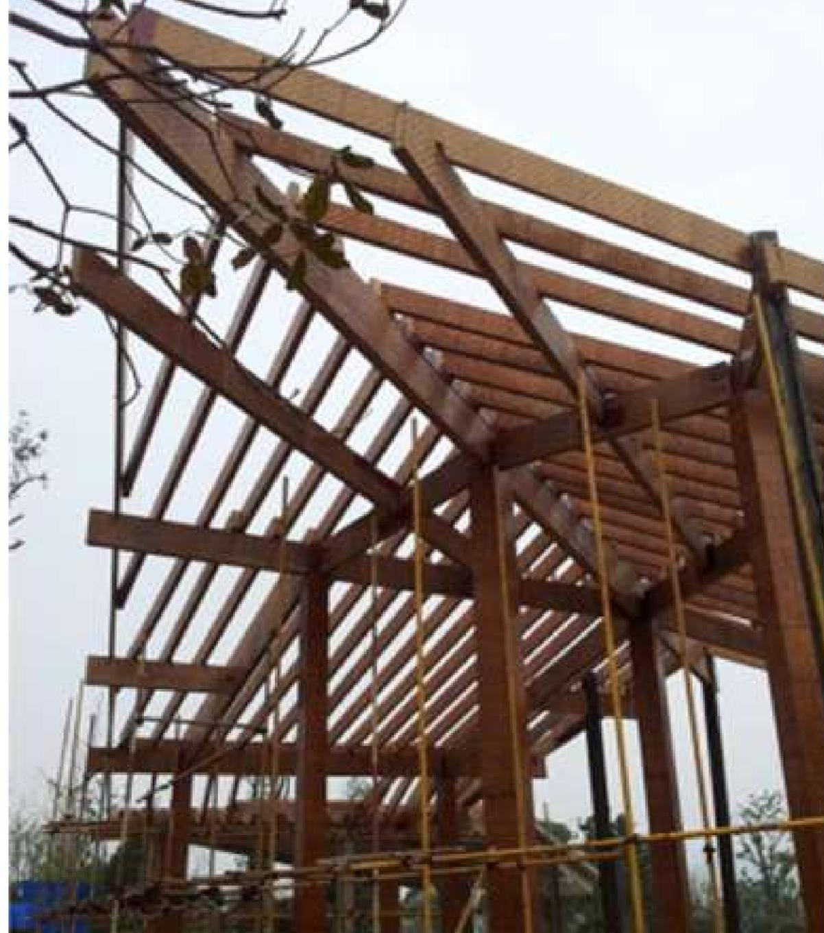
Figura 42: Estructura de bambú laminado.
