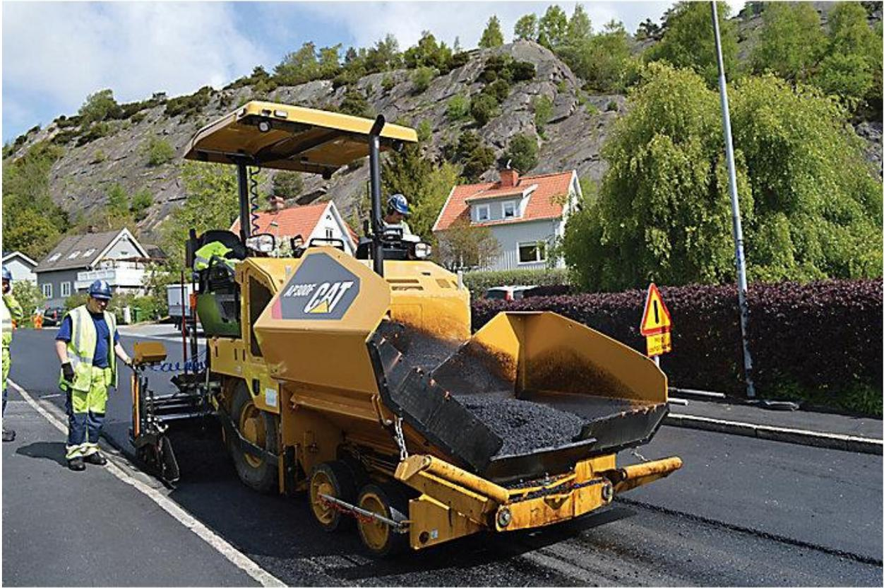
*Figura 35. Muestreo de mezcla asfáltica en camino antes de la compactación en carretera
