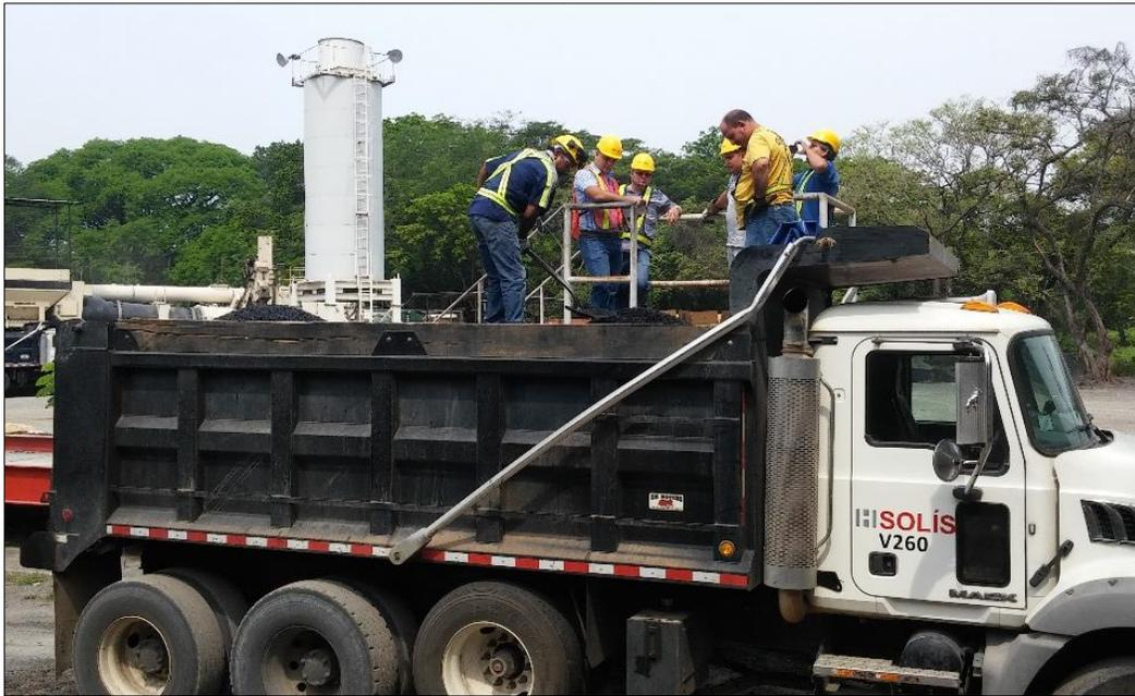
*Figura 34. Muestreo de mezcla asfáltica en camión
