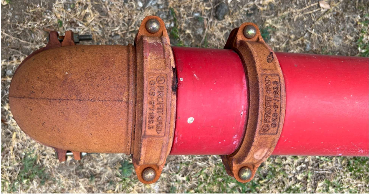
Figura 9. Tubería superficial instalada.
