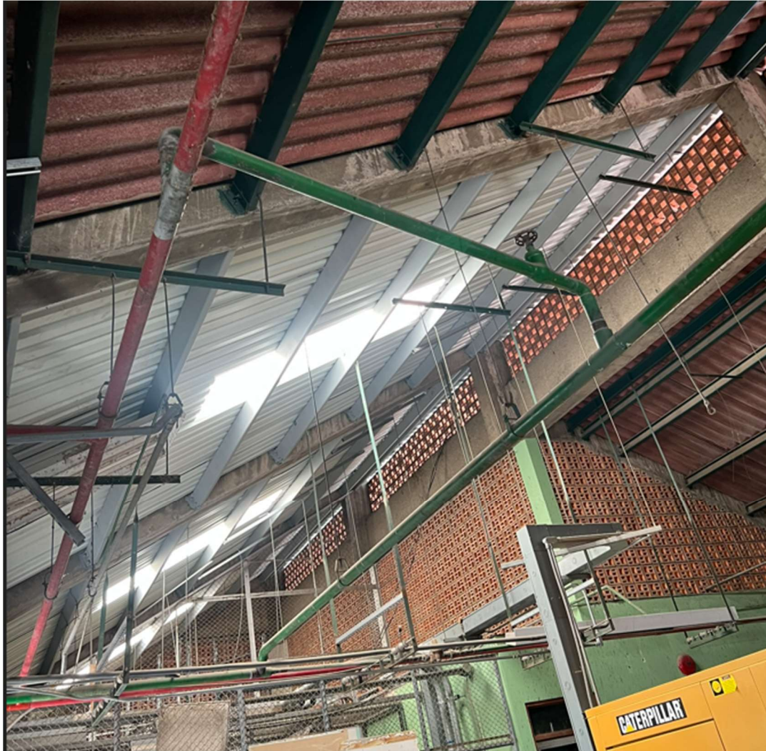
Figura 4. Conexión a Sistema de Potable. Fuente: fotografía tomada por estudiante, 2024.
