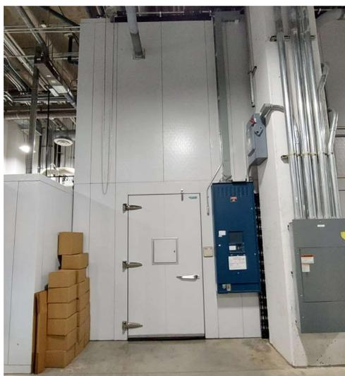
Figura 18. Cámara de ambiente controlado Conviron CMP5000. Fuente: elaboración propia
