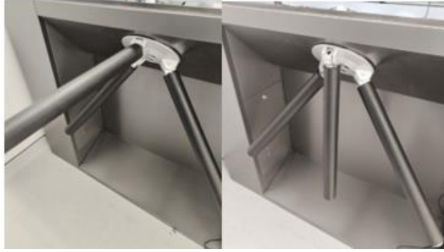
Figura 4-12. Ejemplo de: a) Sujeción del brazo de bloqueo. b) Caída del brazo de bloqueo.
