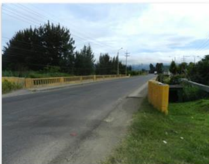
Figura 5. Fotografía del puente piloto, puente "Purires"
