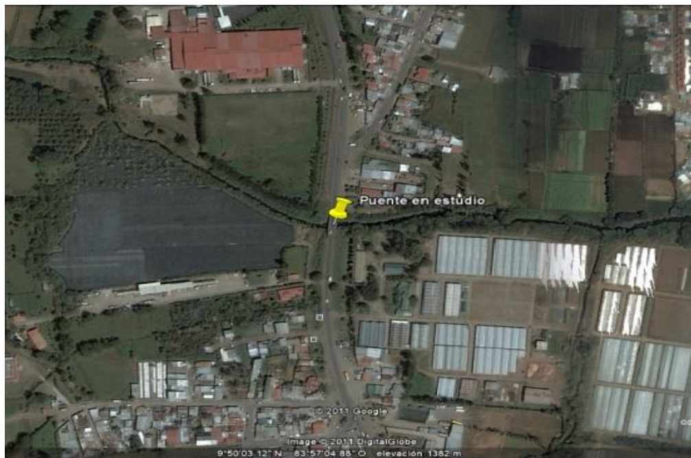
Figura 1. Vista aérea del puente sobre Río Purires (fuente Google Earth)
