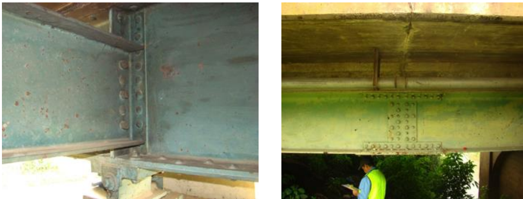
Figura 8. Fotografías de uniones típicas entre vigas
