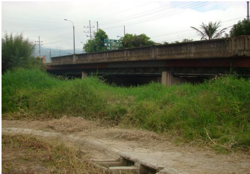
Figura 2. Fotografía lateral del puente sobre Río Purires (fuente propia)
