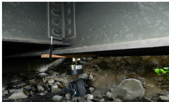
Figura 52. Instalación de sensor SR50A
