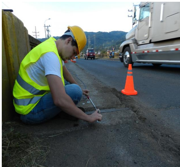
Figura 65. Instalación de sensores en Juntas de expansión.
