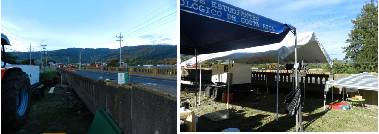
Figura 57. Instalación de campamento y equipos.
