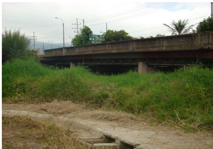
Figura 6. Fotografía lateral del puente piloto, puente “Purires”
