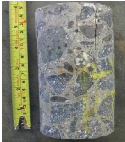
Figura 12. Ejemplo de uno de los núcleos extraídos en el bastión del puente piloto
