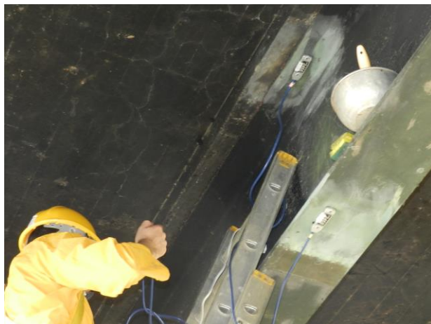
Figura 62. Preparación para la instalación de sensores
