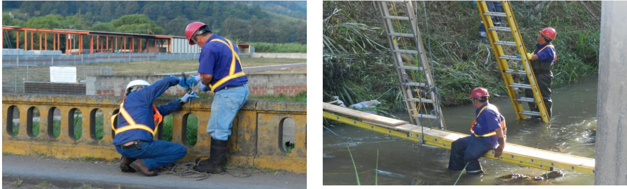
Figura 56. Instalación de líneas de vida y escaleras
