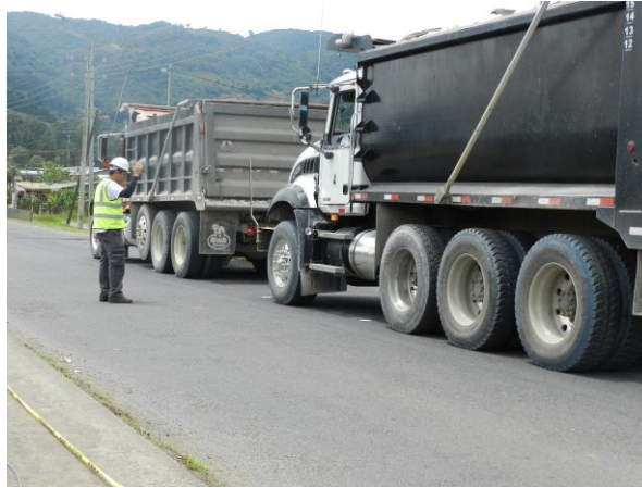
Figura 68. Colocación de vagonetas, prueba estática
