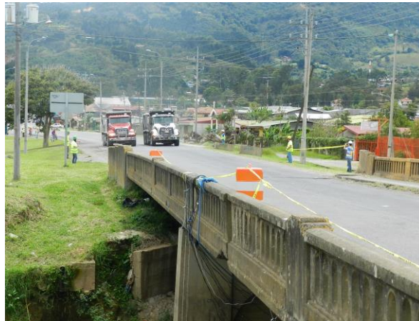
Figura 70. Prueba dinámica, condición III
