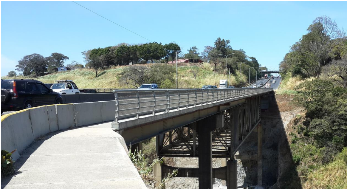
Figura 30. Vista del puente, febrero 2014.
