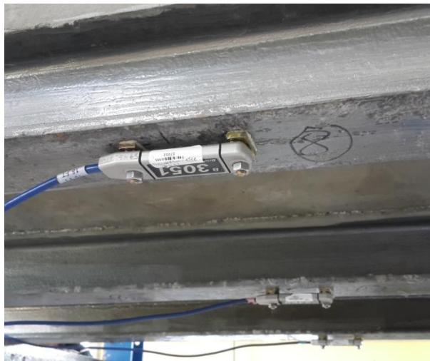
Figura 39. Instrumentación deformímetros en las vigas de acero I.
