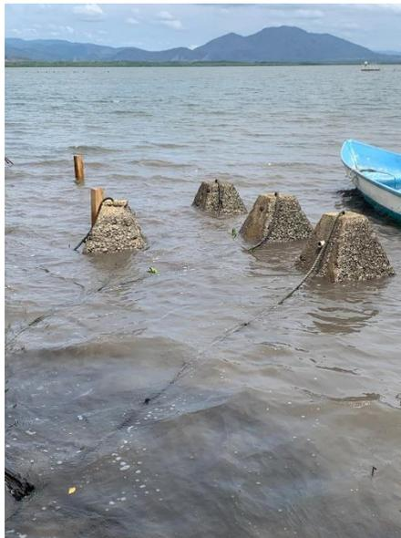
**Figura 4.7: Bloques para anclar las lanternas y canastas en Isla Chira.**
