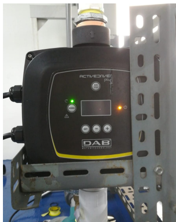
Figura 6.24. Variador de frecuencia DAB Active Driver Plus.
