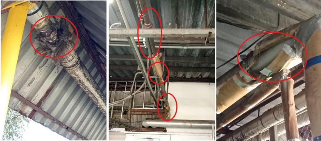
**Figura No 24.** Ejemplos de mal aislamiento del sistema de vapor.
