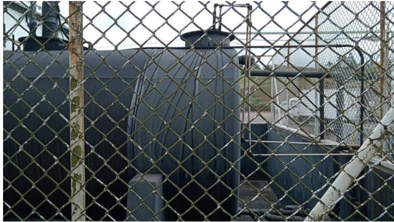
***Figura No 15. Calentador de Búnker C.***
