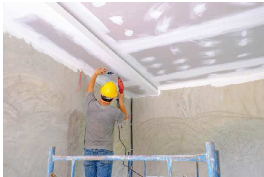
Figura 121. Fotografía de la instalación de un cieloraso de gypsum. Fuente: maestros.com.co
