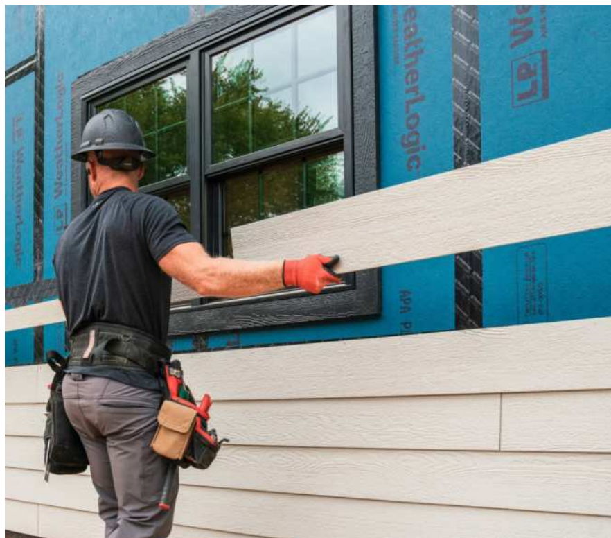
Figura 113. Fotografía de instalación de un revestimiento exterior tipo siding. Fuente: es.lpcorp.com
