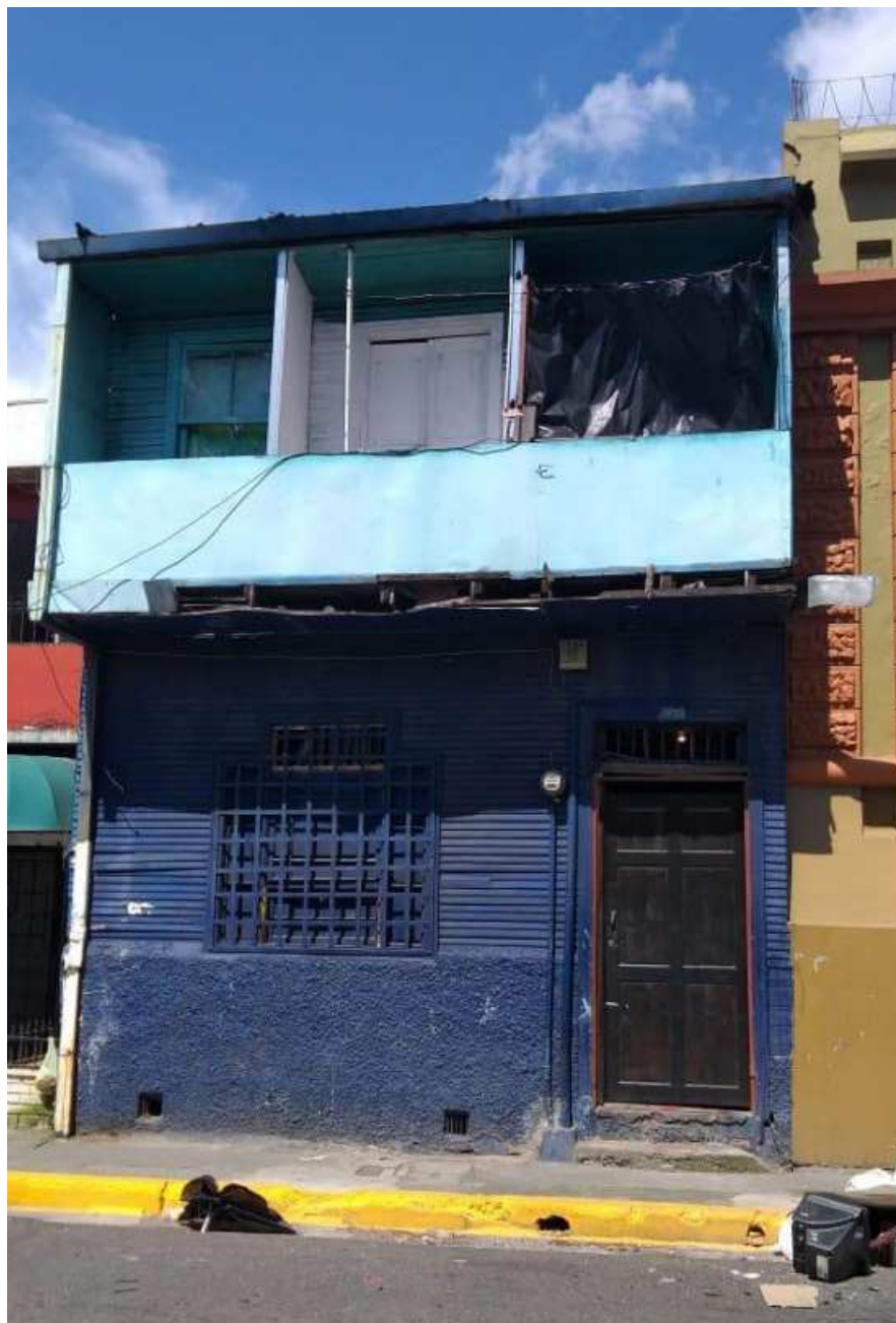
Figura 63. Fotografía de un cuarto en cuartería. Fuente: Policía Municipal de San José.
