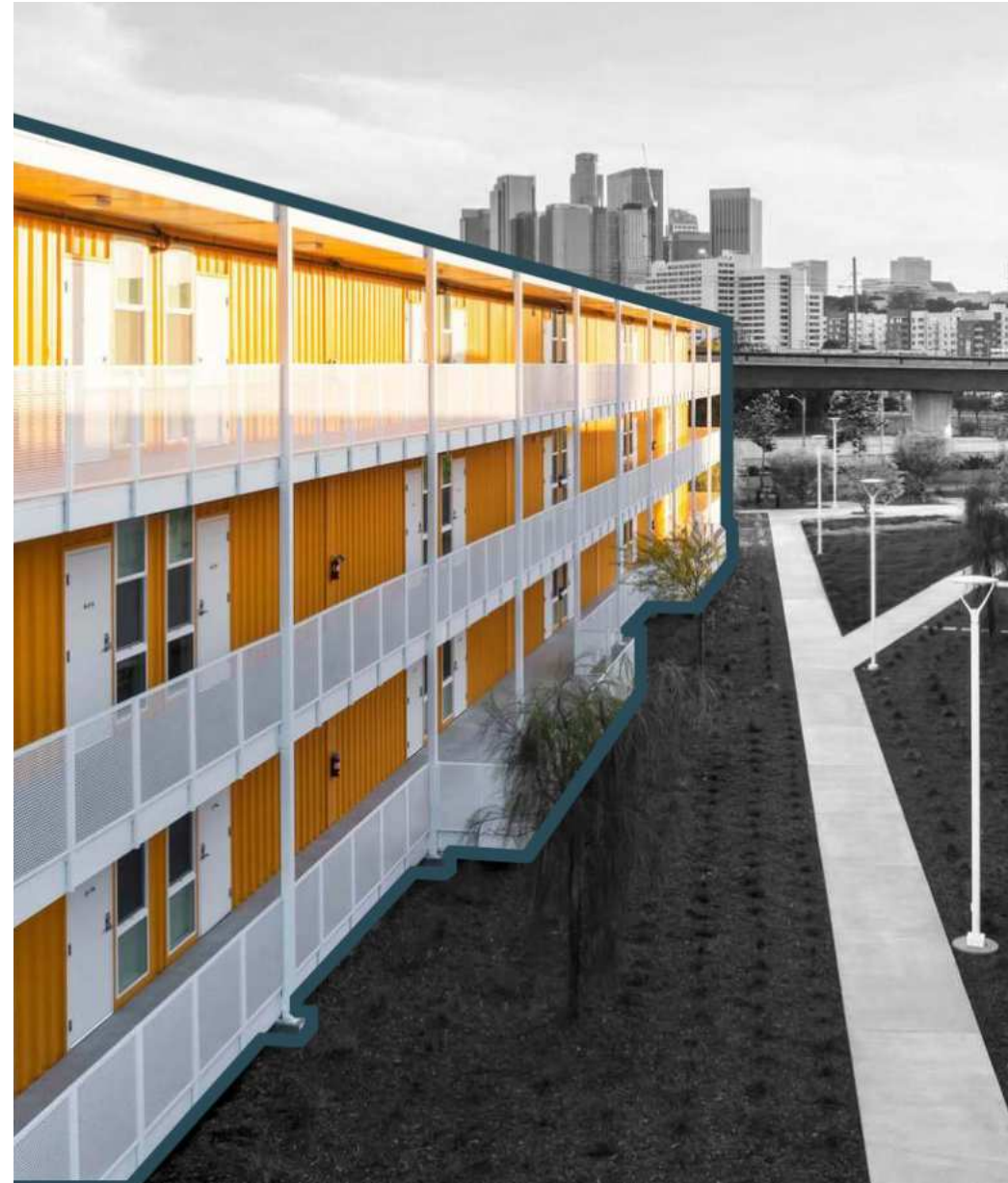
Figura 41. Complejo de vivienda social con contenedores en Los Ángeles, California. Fuente: Elaboración propia con imagen de Archdaily.com
