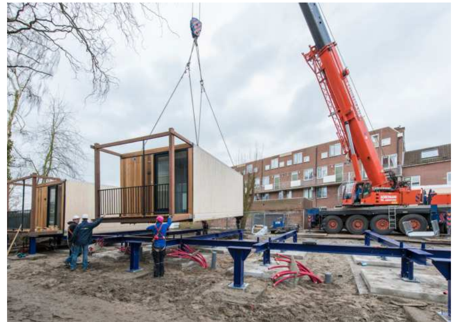
Figura 35. Instalación de módulo de Finch Buildings. Fuente: decirculairebouwcatalogus.nl
