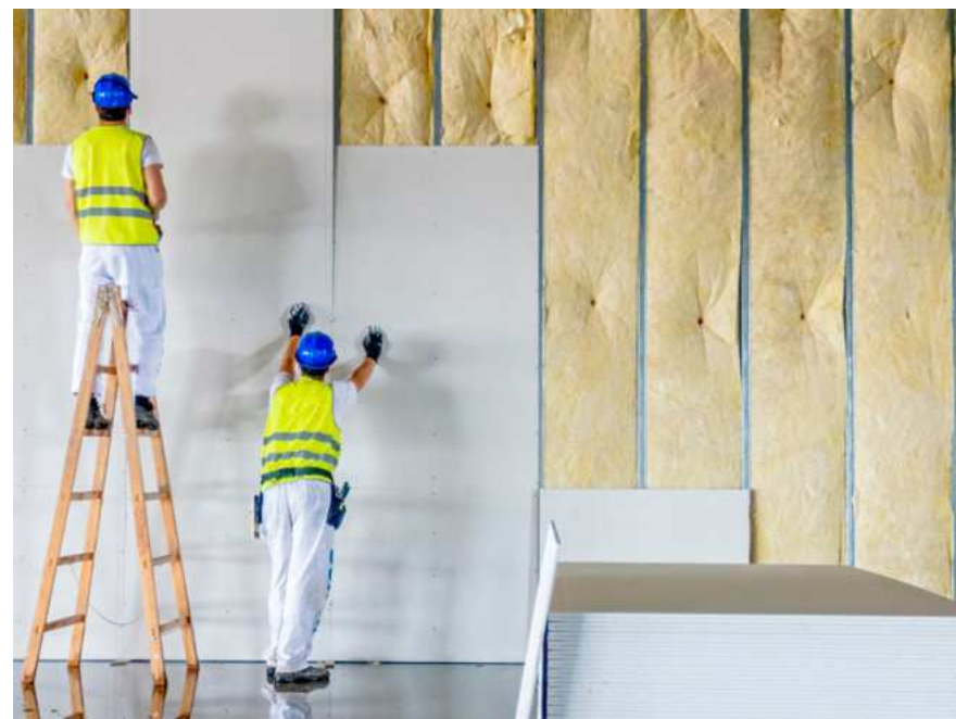
Figura 108. Fotografía de construcción de muro liviano con aislante térmico y acústico de lana de vidrio. Fuente: tektron.com
