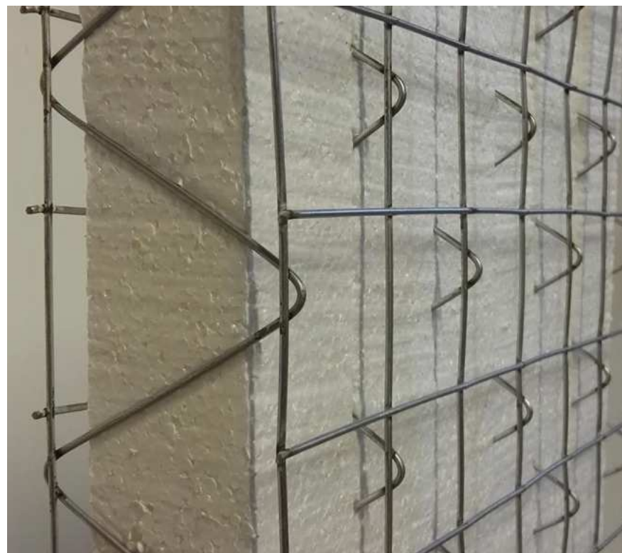
Figura 112. Fotografía de panel de poliestireno expandido con malla electrosoldada. Fuente: panelcocr.com
