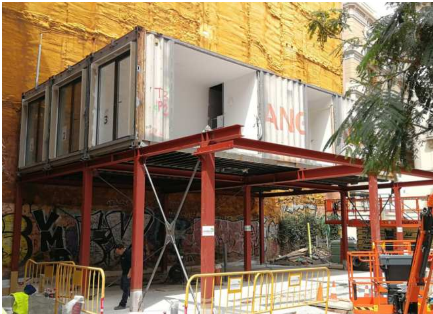
Figura 47. Construcción de primer edificio APROP en Barcelona. Fuente: Archdaily.com
