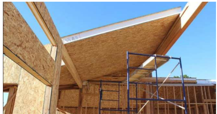
Figura 126. Fotografía de panelización modular de viviendas de madera en Costa Rica.
