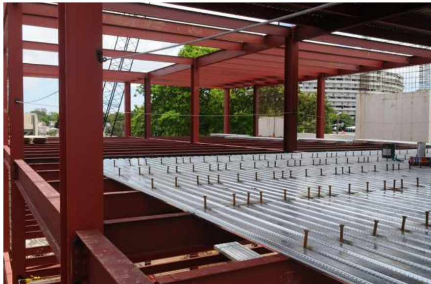
Figura 119. Fotografía de un entresijo de metaldeck en construcción. Fuente: acesco.com.
