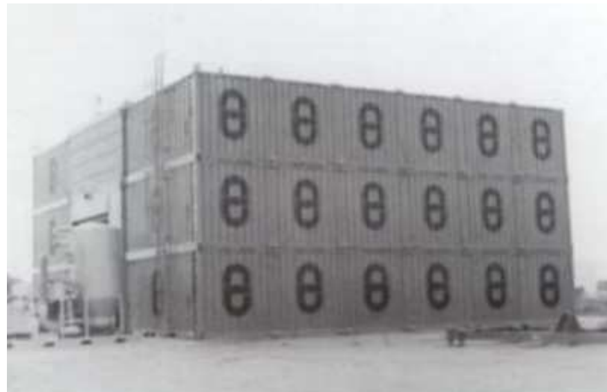
Figura 36. Posible primer edificio de contenedores, almacén diseñado por Steadman Contenedores preparado para la carga de cemento. Fuente: VESL S.R.L contenedores.com, s.f
