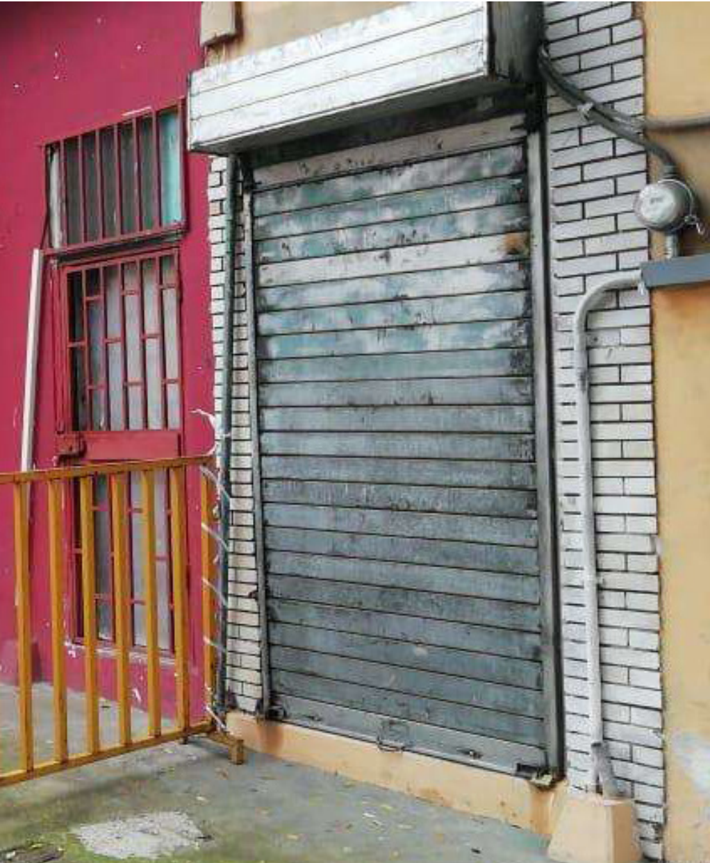
Figura 51 y 52. Fachada exterior de una cuartería en cuarentena durante la pandemia por COVID-19 en Barrio Amón, Carmen. Fuente: Fotografía de Teletica.com
