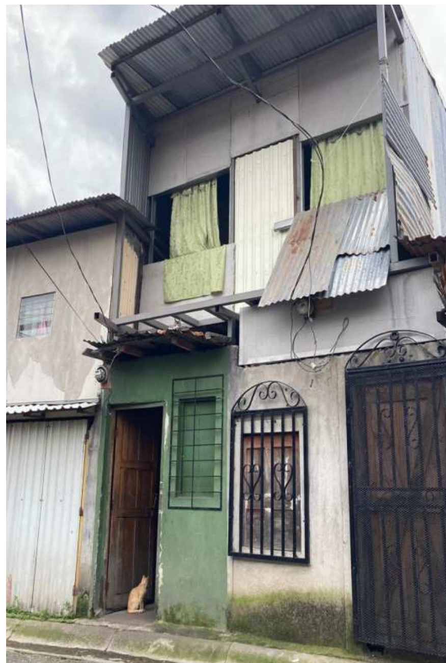
Figura 61. Fotografía de un cuarto en cuartería. Fuente: Policía Municipal de San José.
