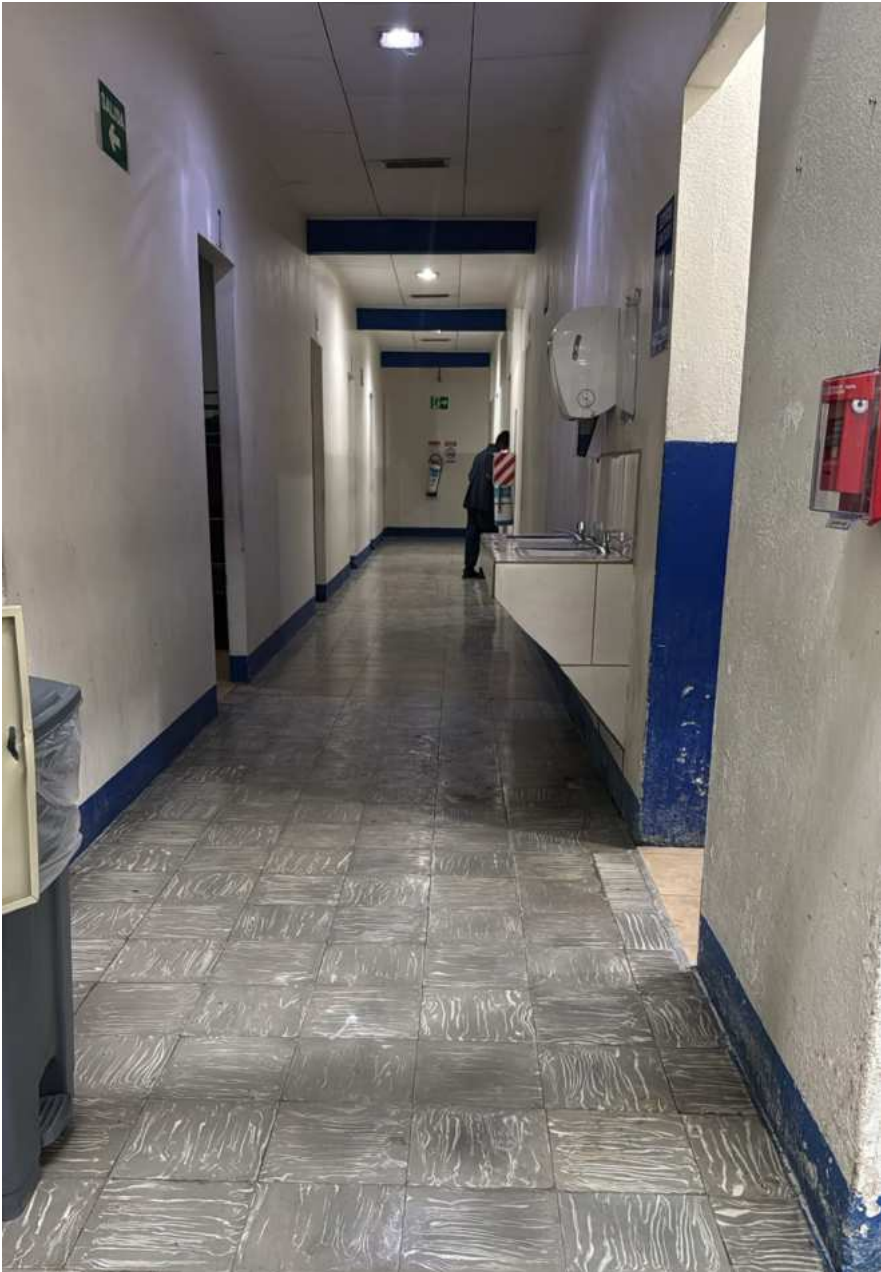
Figura 68. Fotografía de la circulación del Dormitorio Municipal de San José. Fuente: Administración del Dormitorio Municipal
