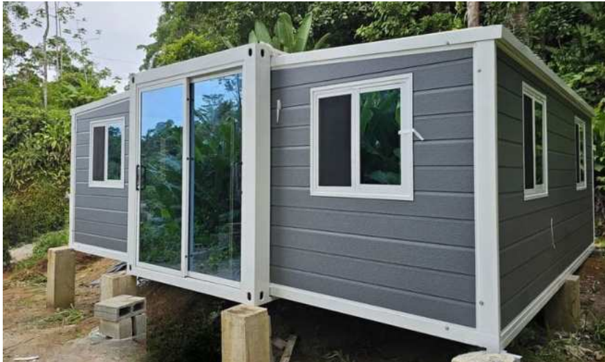
Figura 16. Proyecto de vivienda modular prefabricada en Cahuita, Limón. Fuente: casasmodularescr.com
