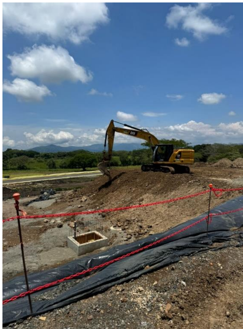
Figura 25. Evidencia fotográfica del proceso constructivo: movimiento de tierras.
