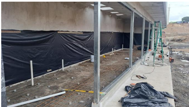
Figura 27. Evidencia fotográfica del proceso constructivo: contrapisos y acabados de pisos.
