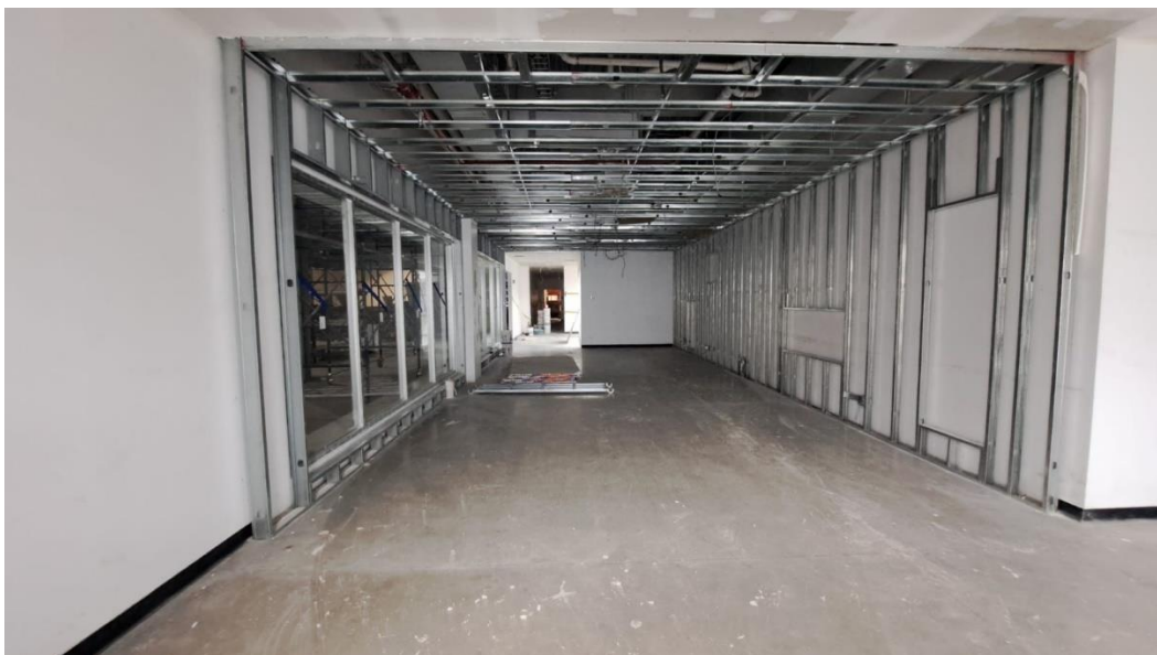
Figura 43. Perfiles para colocación de paneles de paredes y cielos livianos.
