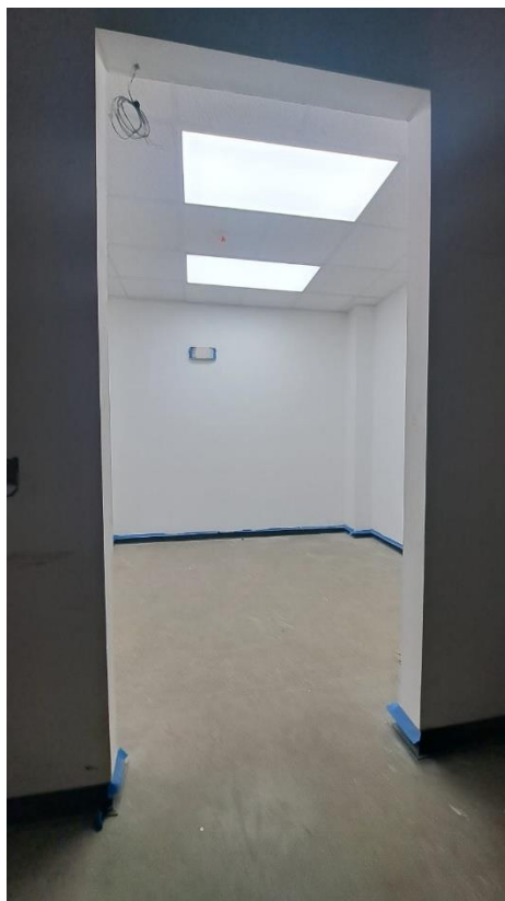
Figura 42. Cielos suspendidos y pintura de cuarto.
