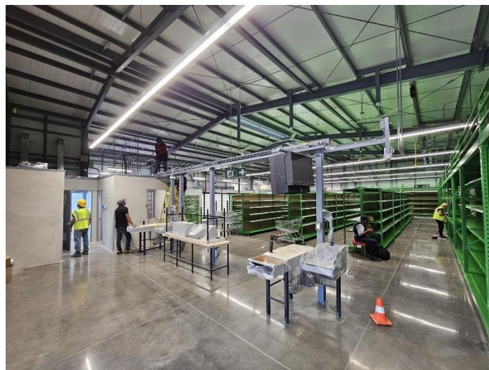
Figura 47. Acabado de pisos.
