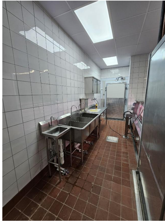
Figura 46. Instalación de enchape en paredes y acabado de pisos.
