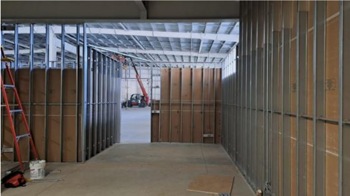
Figura 30. Evidencia fotográfica del proceso constructivo: paredes de mampostería.
