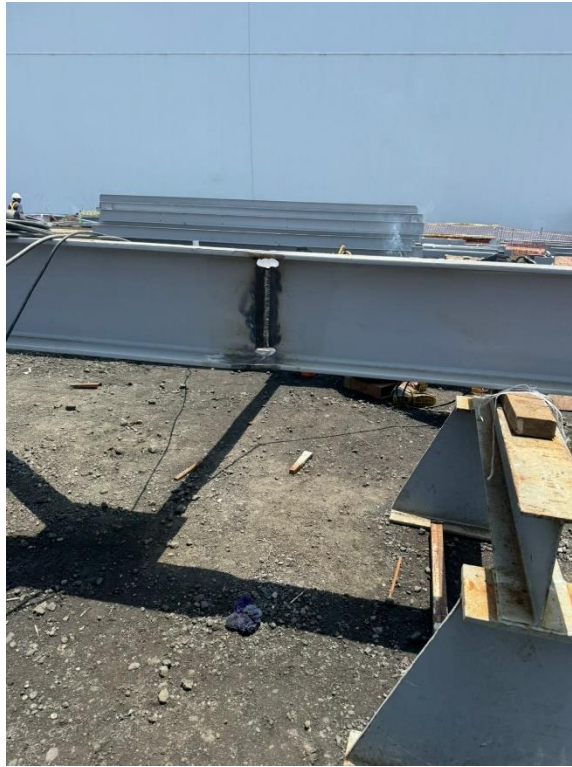
Figura 59. Soldadura de estructura metálica.
