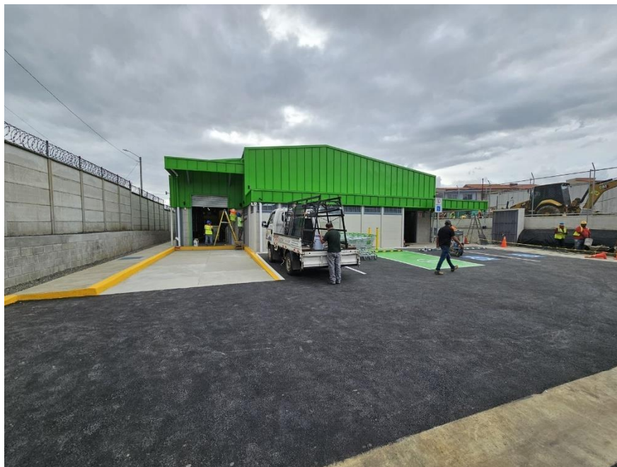
Figura 51. Cubierta de nave finalizada y con pintura aprobada por cliente.
