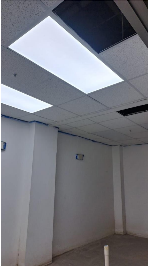
Figura 37. Evidencia fotográfica del proceso constructivo: instalación de cielos.
