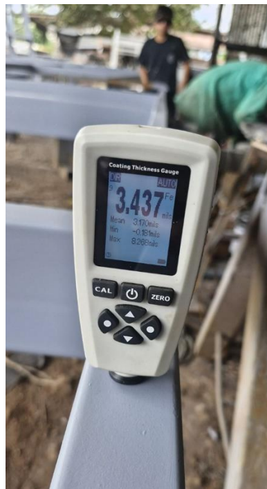
Figura 35. Evidencia fotográfica del proceso constructivo: estructura metálica.
