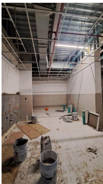
Figura 32. Evidencia fotográfica del proceso constructivo: enchape de paredes.
