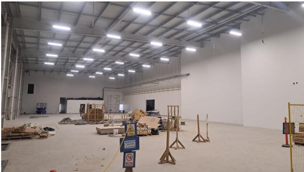
Figura 45. Cubierta de techo finalizada.
