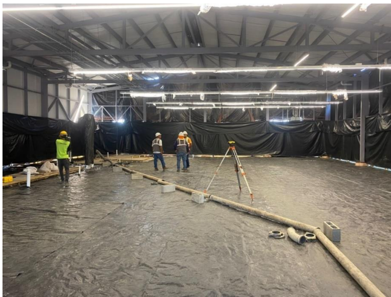
Figura 10. Nave industrial en ejecución por DICOMA Construcción.
