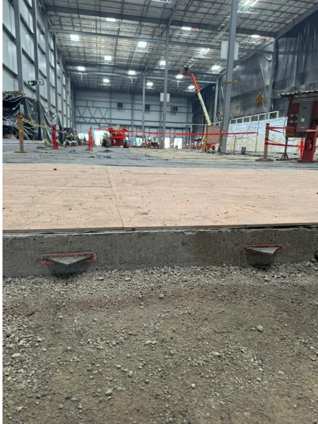
Figura 52. Losa de contrapiso.
