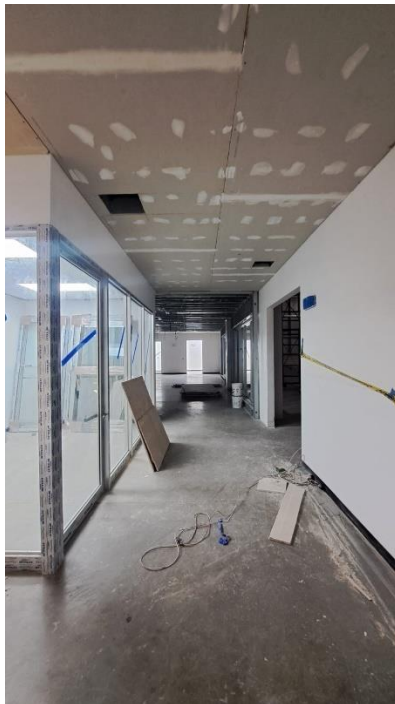
Figura 41. Empastado de juntas de cielos livianos.
