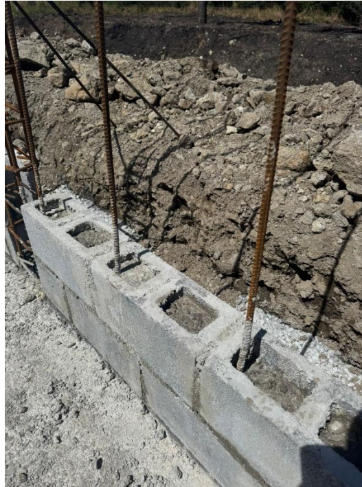
Figura 29. Evidencia fotográfica del proceso constructivo: paredes de mampostería.
