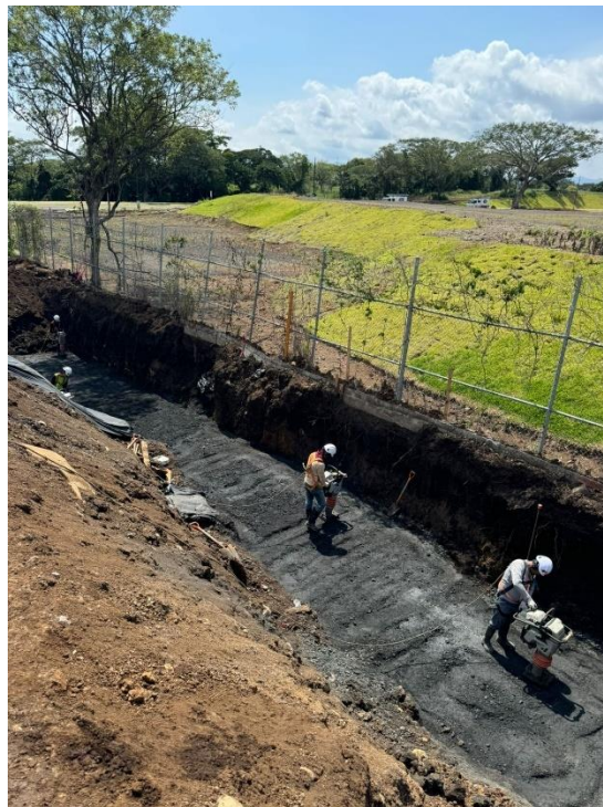
Figura 60. Compactación de material de lastre en zona de muro contención.
