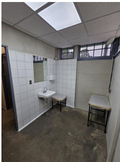
Figura 31. Evidencia fotográfica del proceso constructivo: enchape de paredes.
