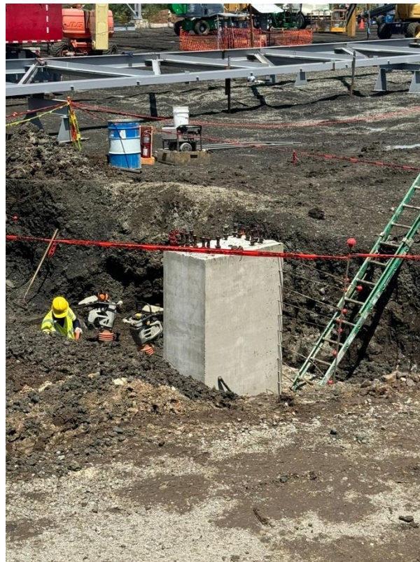
Figura 56. Pedestal de concreto reforzado para apoyo de columna metálica.
