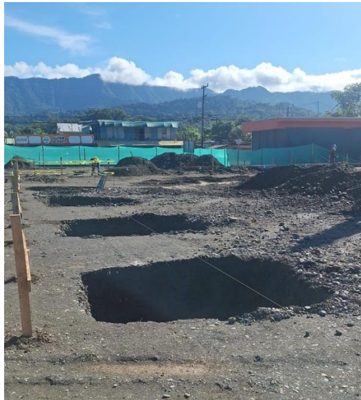
Figura 26. Evidencia fotográfica del proceso constructivo: fundaciones.
