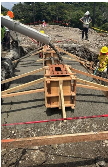
Figura 34. Colado de concreto (cuarta medición).
