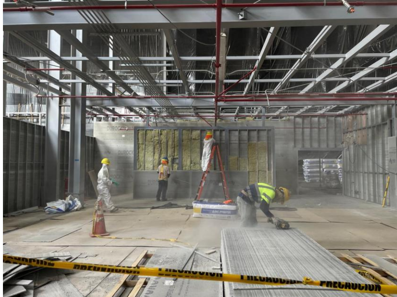
Figura 26. Colocación fibra en paredes livianas (primera medición).
