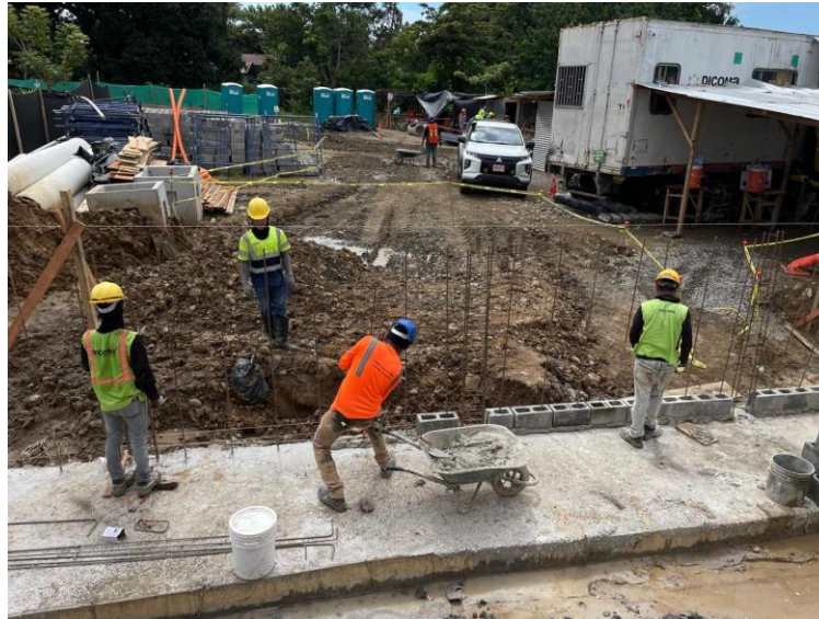
Figura 29. Colocación de bloques de mampostería (primera medición).
