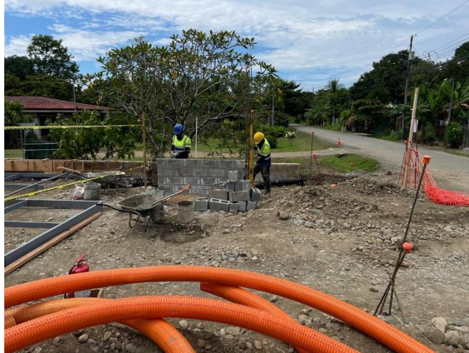
Figura 31. Colocación de bloques de mampostería (segunda medición).
