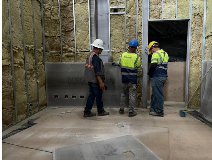
Figura 24. Colocación lámina durock (segunda medición).
