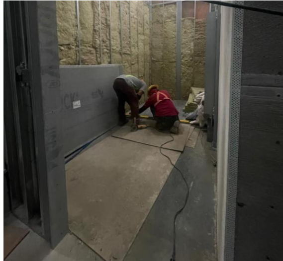
Figura 22. Colocación lámina Durock (primera medición).
