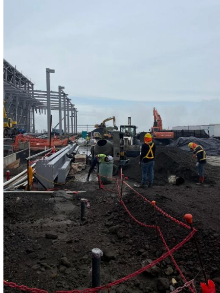
Figura 17. Fabricación de concreto con batidora 0,45 m 3 .
