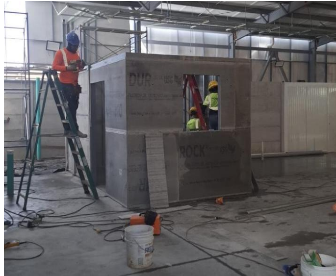
Figura 35. Colocación de lámina Durock Ciudad Cortés.
