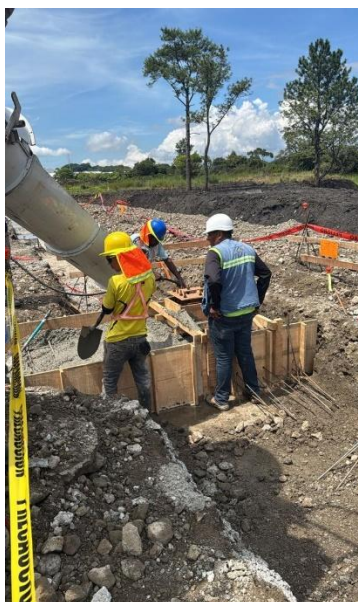
Figura 33. Colado de concreto (segunda medición).
