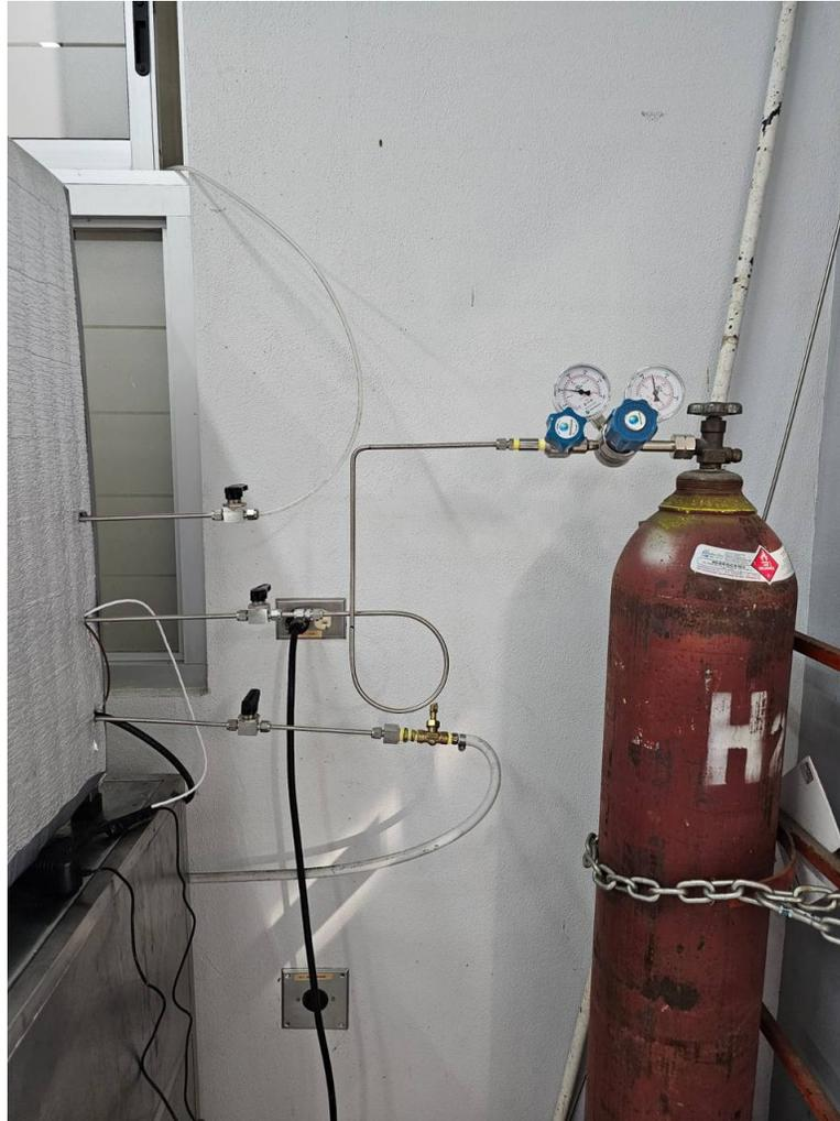
**Figura 4.30:** Conexión entre tanque de hidrógeno y sistema con conexión de tubería de acero inoxidable.
