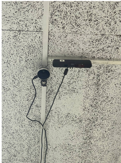
Figura 4.3: Montaje de la cámara RealSense L515 en el entorno de trabajo. Elaboración propia.
