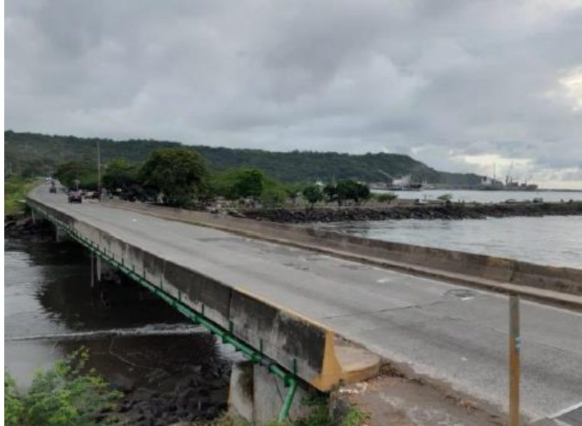
Figura 14. Vista general del puente sobre el Estero Mata, Ruta Nacional 23. Año 2022
