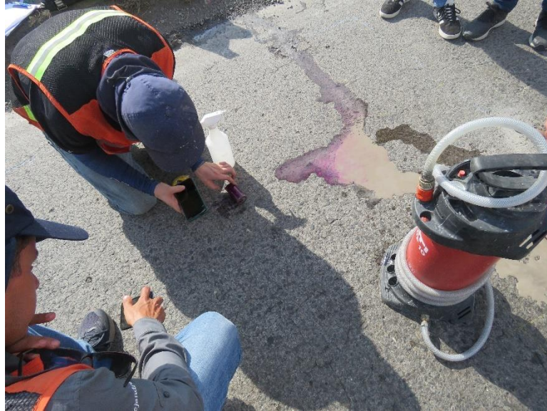
Figura 33. Prueba de cloruros en losa.
