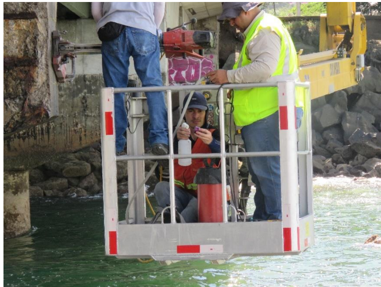
Figura 34. Extracción de núcleos y prueba de cloruros.
