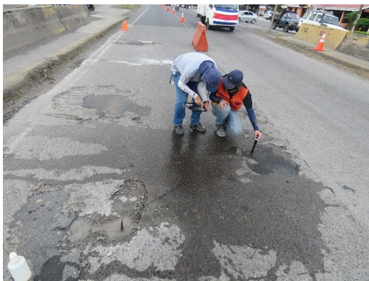
Figura 31. Aplicación de celda medía en losa.
