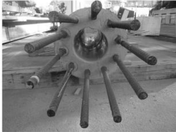
Figura 2. Detalle de acero saliendo de columna de prefabricado
