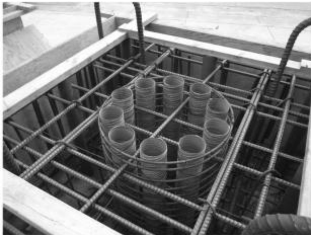
Figura 3. Detalle de columna dentro del molde con ductos para ensamble en sitio
