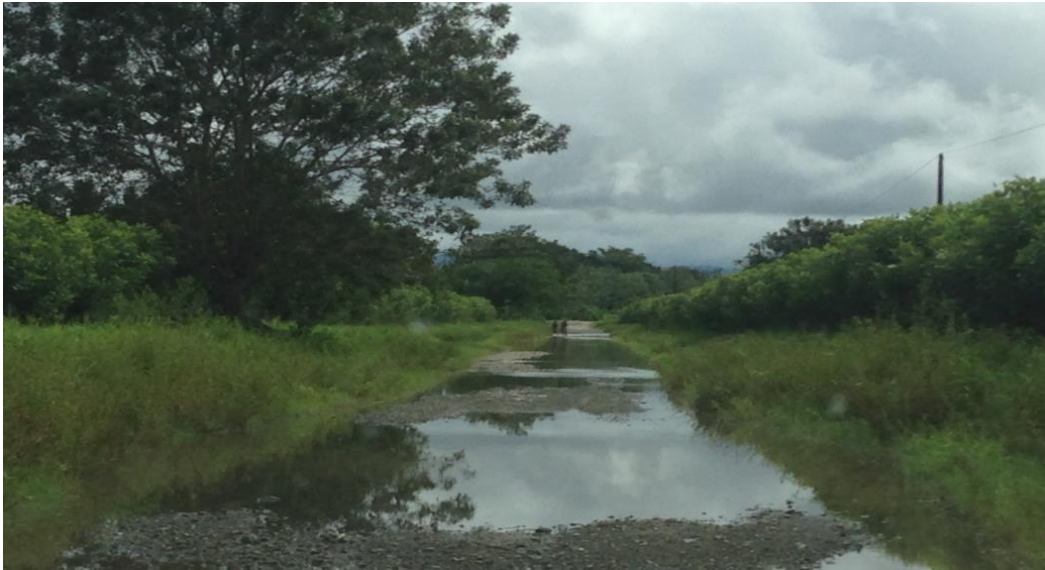
Figura 11 Camino a Agroindustrial de Golfito, parcialmente inundado.
