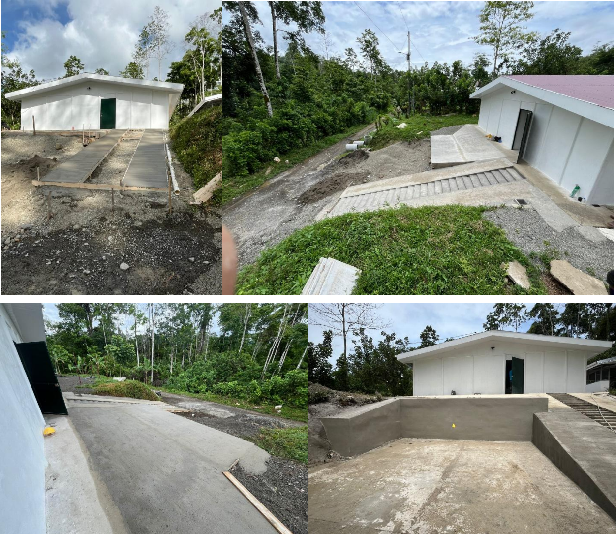
Figura 18. Construcción de rampa de acceso, zona de carga y descarga.
