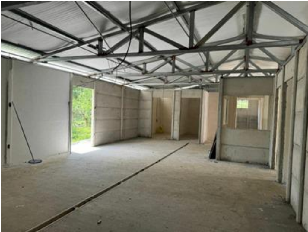
Informe 10. Figura 1. Colado de contrapiso e inicio de repello de paredes internas del área de procesamiento
