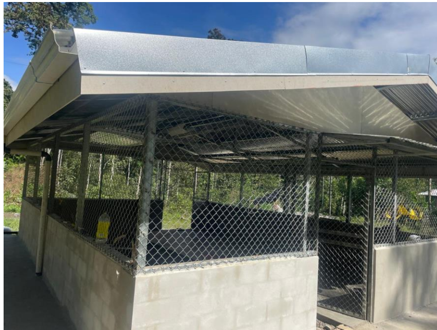
Informe 3. Figura 1. Vista general de construcción de área de fermentado
