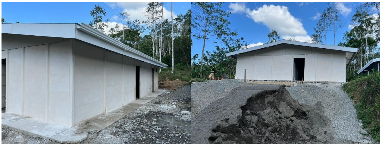
Figura 16. Vista general de área de acopio
