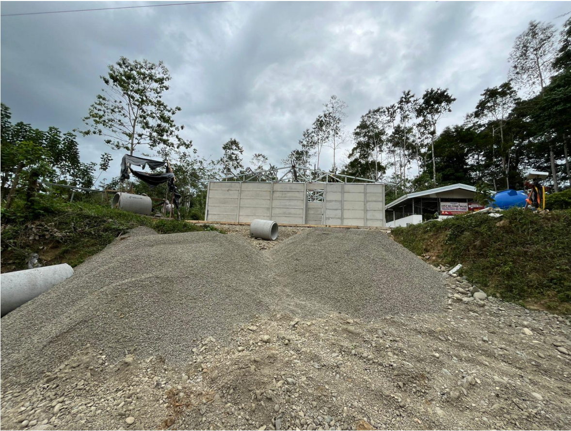
Informe 6. Figura 2. Entrega de agregados usados en el concreto del proyecto
