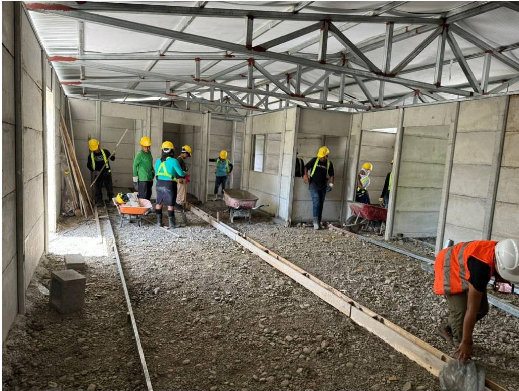
Informe 9. Figura 1. Colado de entepiso área de procesamiento
