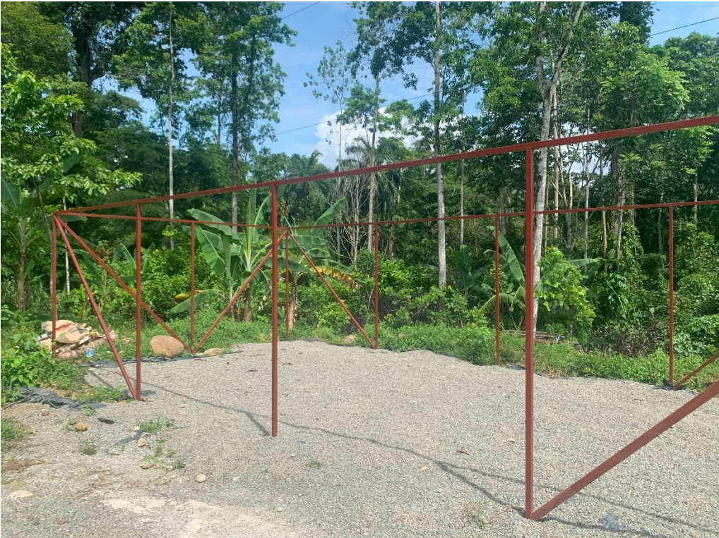
Informe 12. Figura 4. Pintado de la base del área de secadores
