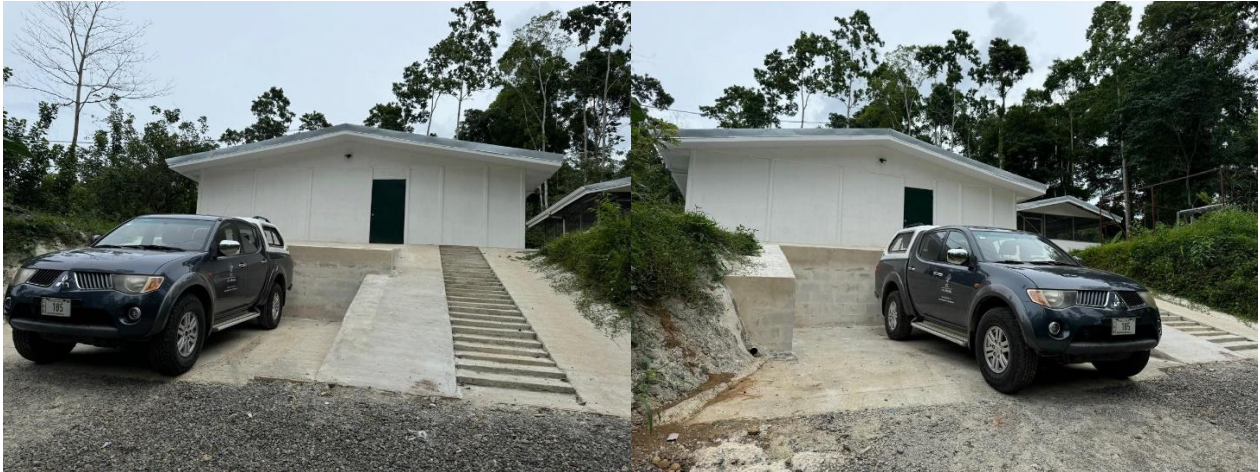
Figura 19. Vista general de rampa de acceso y zona de carga y descarga
