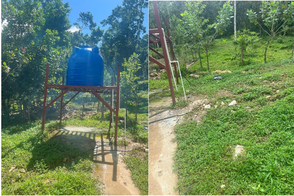
Informe 14. Figura 1. Mala manipulación del tanque de almacenamiento de agua
