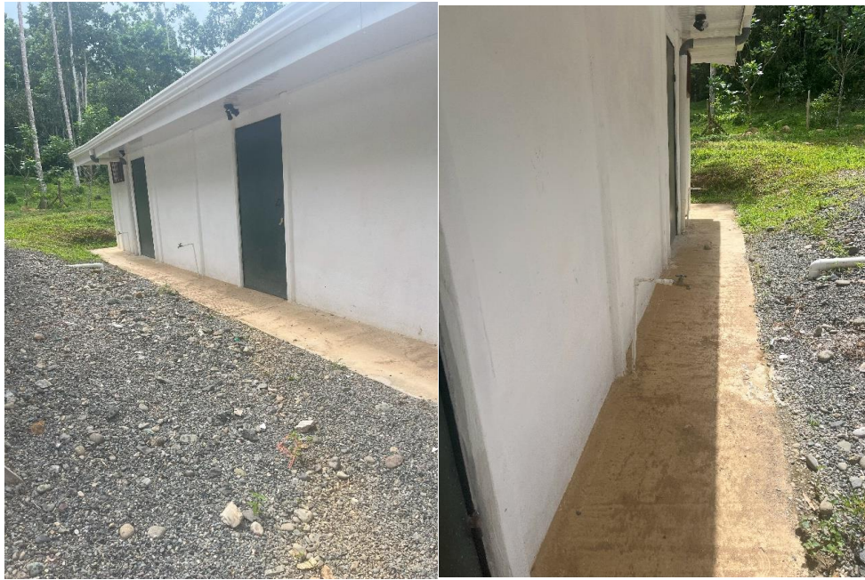
Informe 14. Figura 5. Pendiente zanja de desalojo de agua y reforzamiento de tubos de agua
