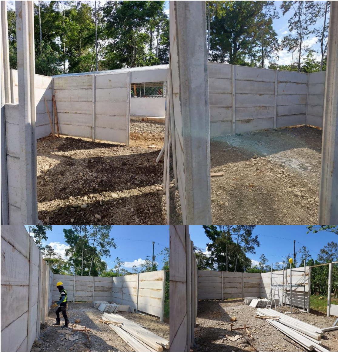
Informe 4. Figura 1. Vista Interna de Levantamiento de Columnas y Paredes de Estructura Principal
