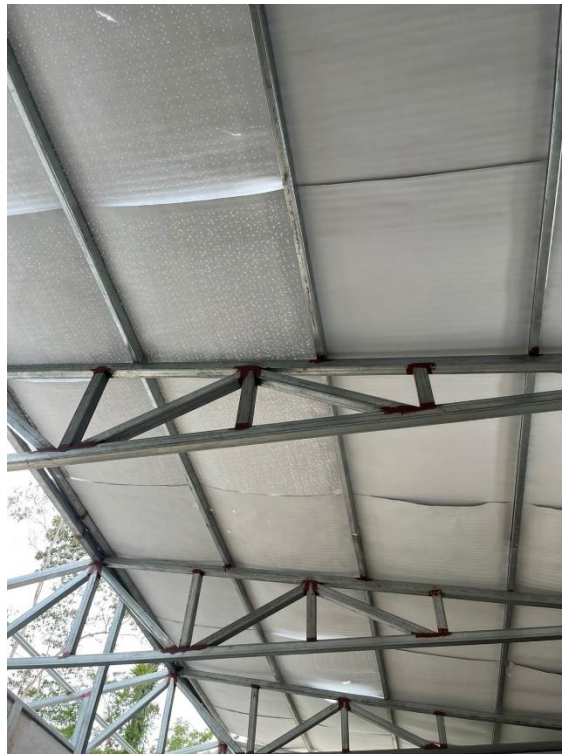
Informe 7. Figura 2. Vista lateral de área de procesamiento, continuación colocación de zinc y aislante térmico
