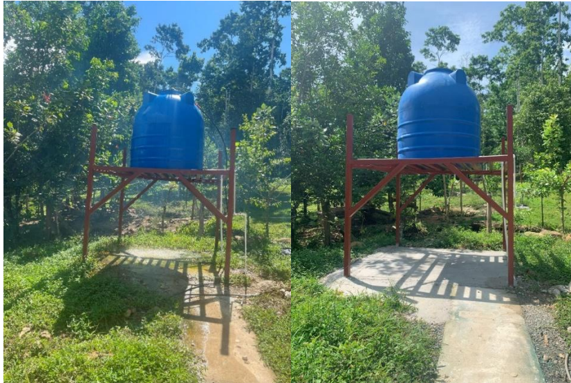
Figura 20. Base elevada de tanque de almacenamiento de agua
