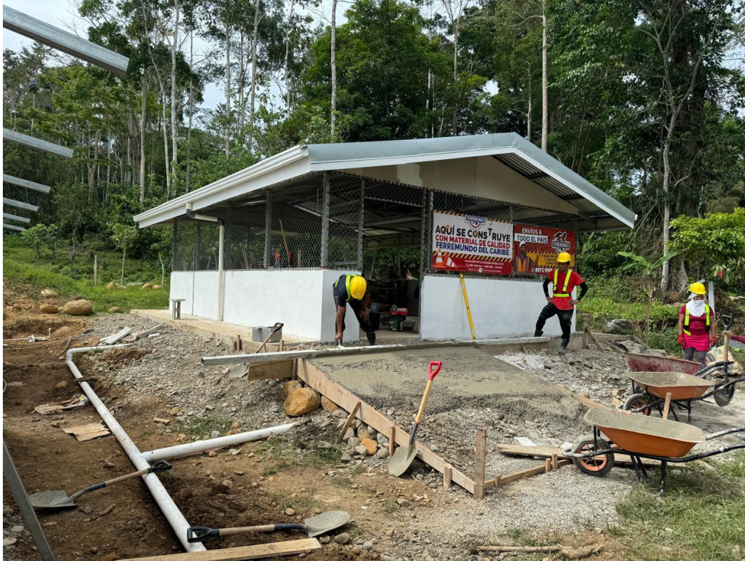
Informe 5. Figura 1. Construcción de rampa de ingreso de área de fermentado
