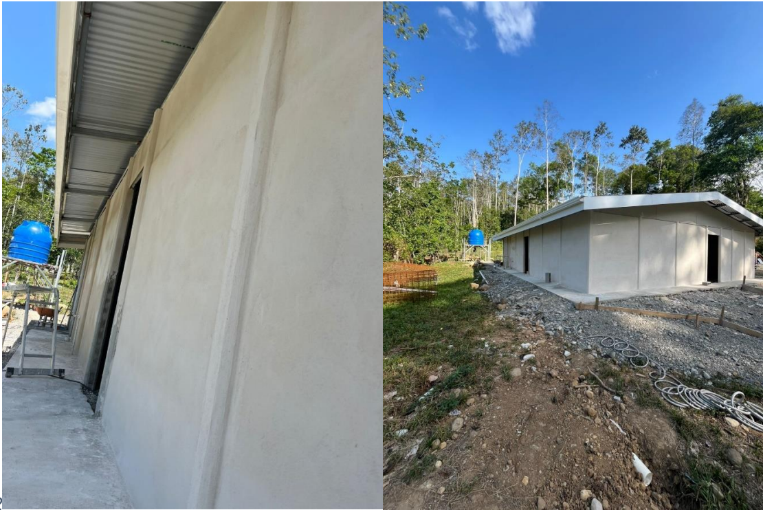
Informe 10. Figura 2. Repello y acabado de exteriores de área de procesamiento
