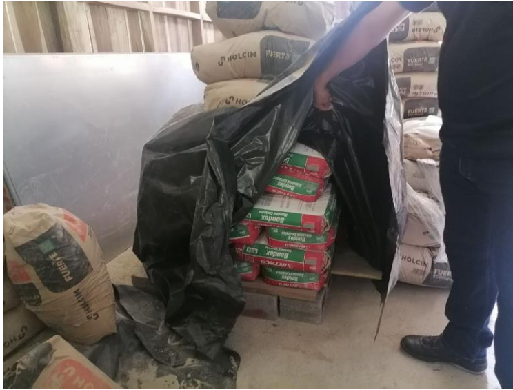
Informe 2. Figura 2. Almacenamiento del cemento de la obra
