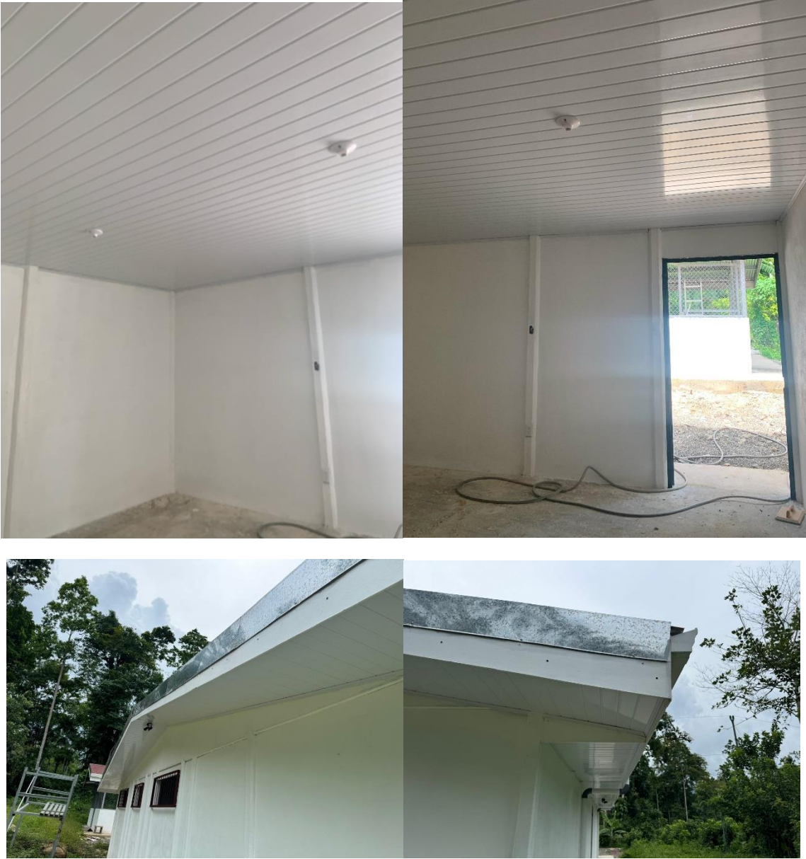
Informe 12. Figura 7. Instalación de cielo raso y plafones en área de procesamiento
