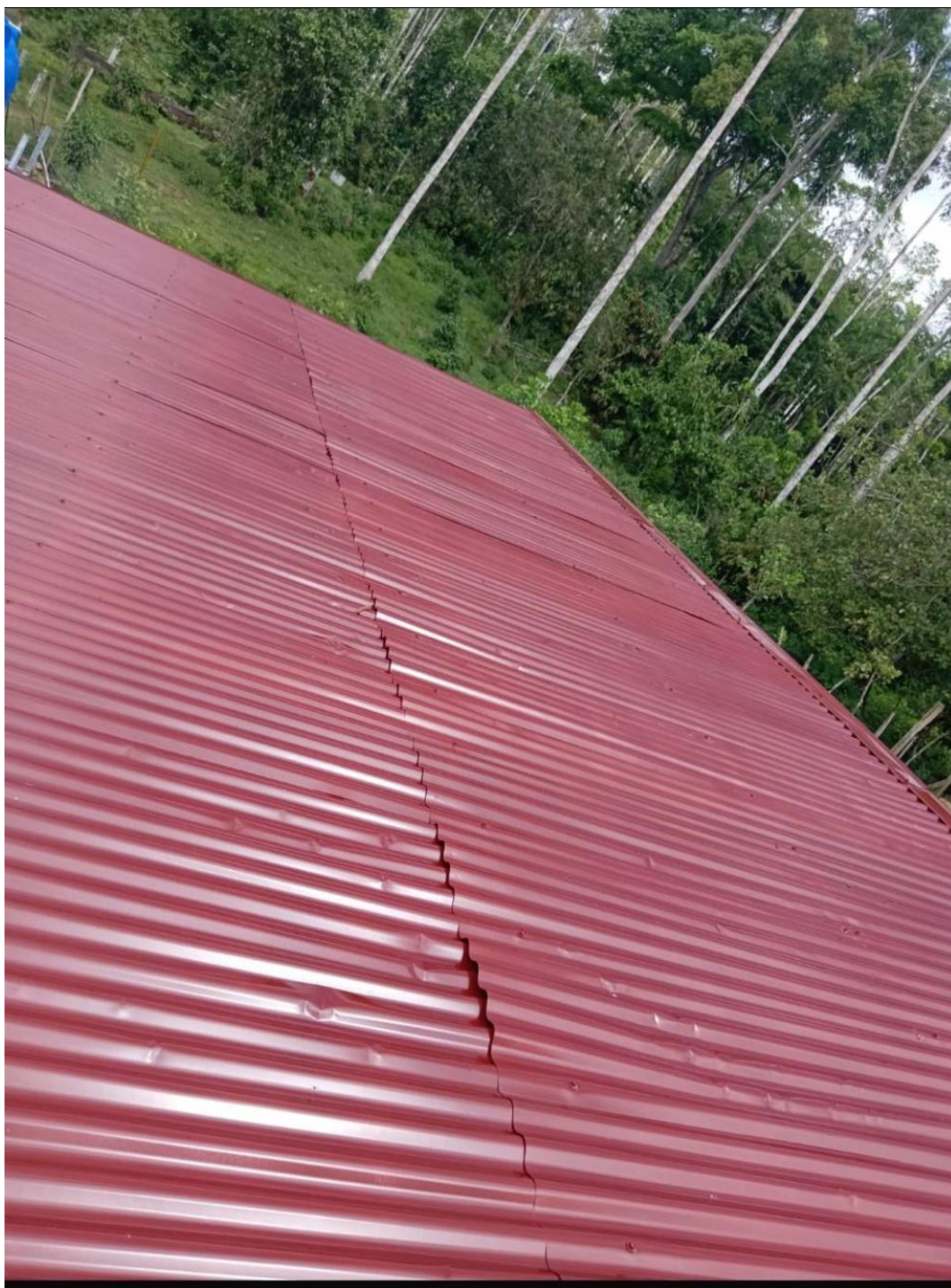
Informe 9. Figura 2. Pintado de zinc del área de procesamiento
