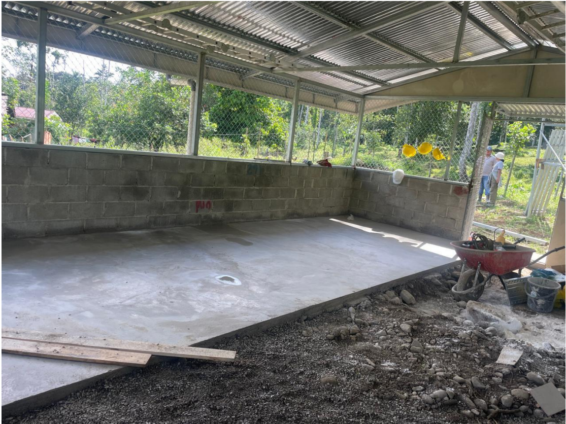
Informe 3. Figura 3. Colado de constrapiso de área de fermentado
