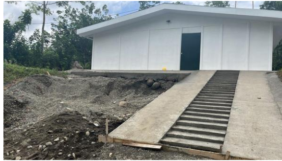
Informe 11. Figura 1. Vista general de rampa de ingreso y escaleras
