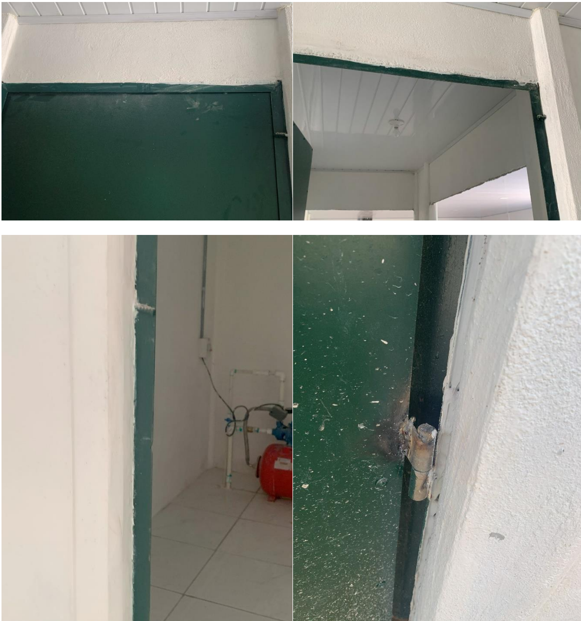
Informe 13. Figura 4. Detalles de acabados, mal pintado de marcos de puertas, desprendimiento de repello
