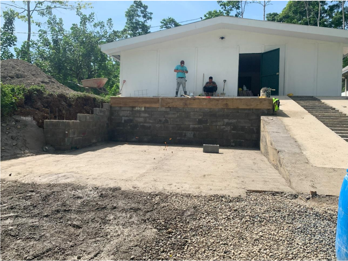
Informe 12. Figura 1. Construcción de zona de carga y descarga del proyecto
