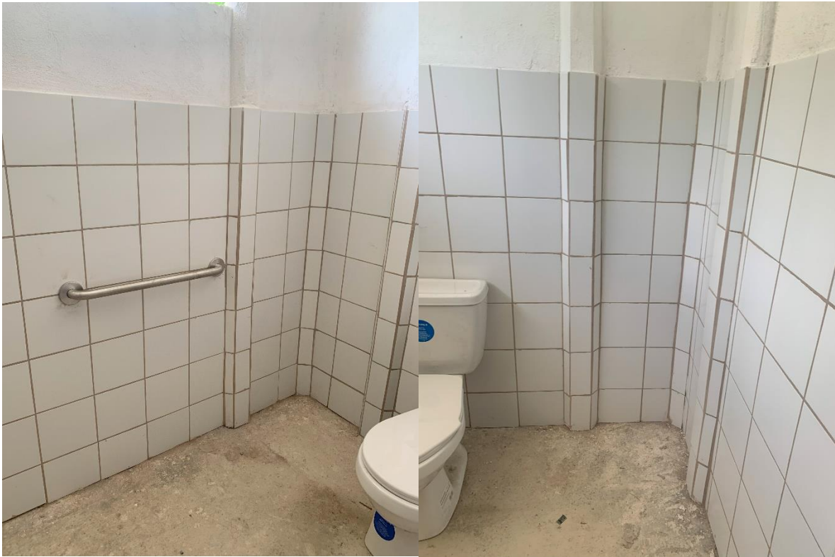
Informe 12. Figura 5. Instalación de cerámica en área de baños de la planta procesadora
