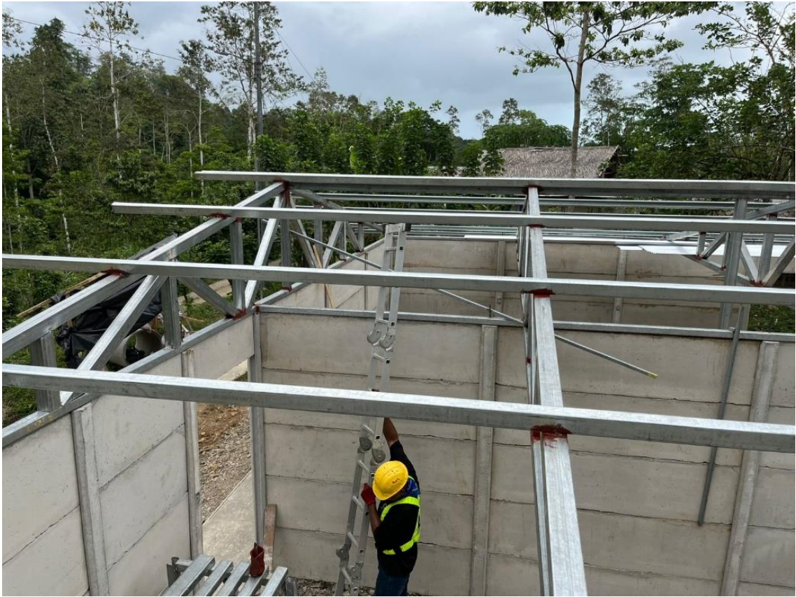
Informe 6. Figura 3. Continuación de construcción de cerchas en área de procesamiento
