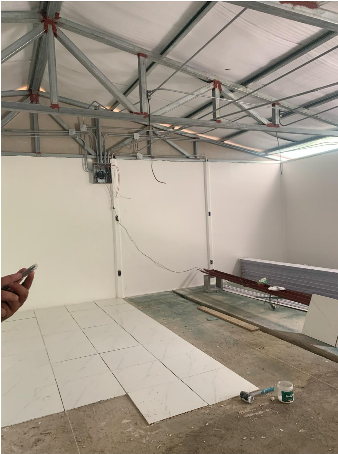
Informe 12. Figura 6. Elaboración de sistema eléctrico, colocación de cerámica en zona principal del área de procesamiento
