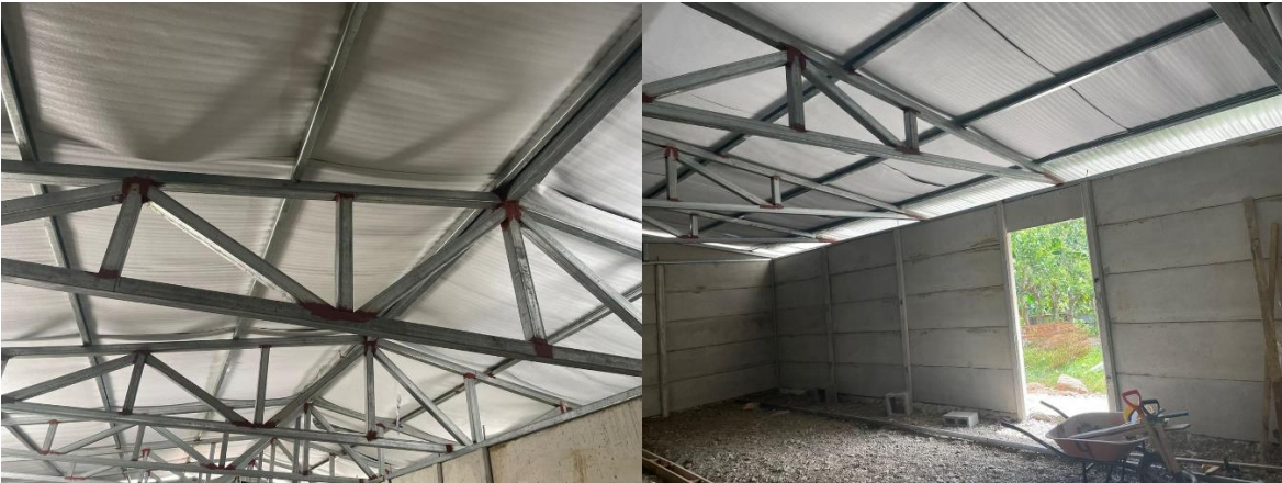
Informe 8. Figura 3. Colocación final de zinc y aislante térmico en área de procesamiento
