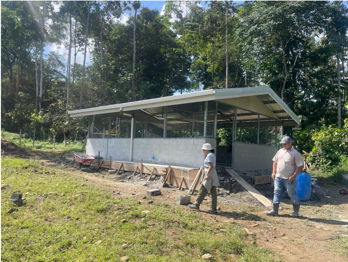
Informe 3. Figura 2. Formateado de acera perimetral, de área de fermentado
