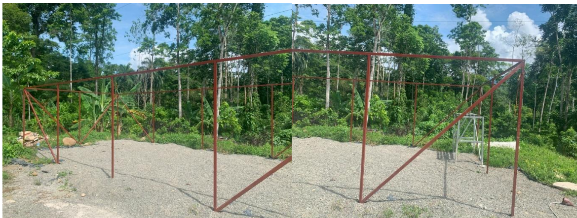
Figura 21. Base de acero del área de secadores
