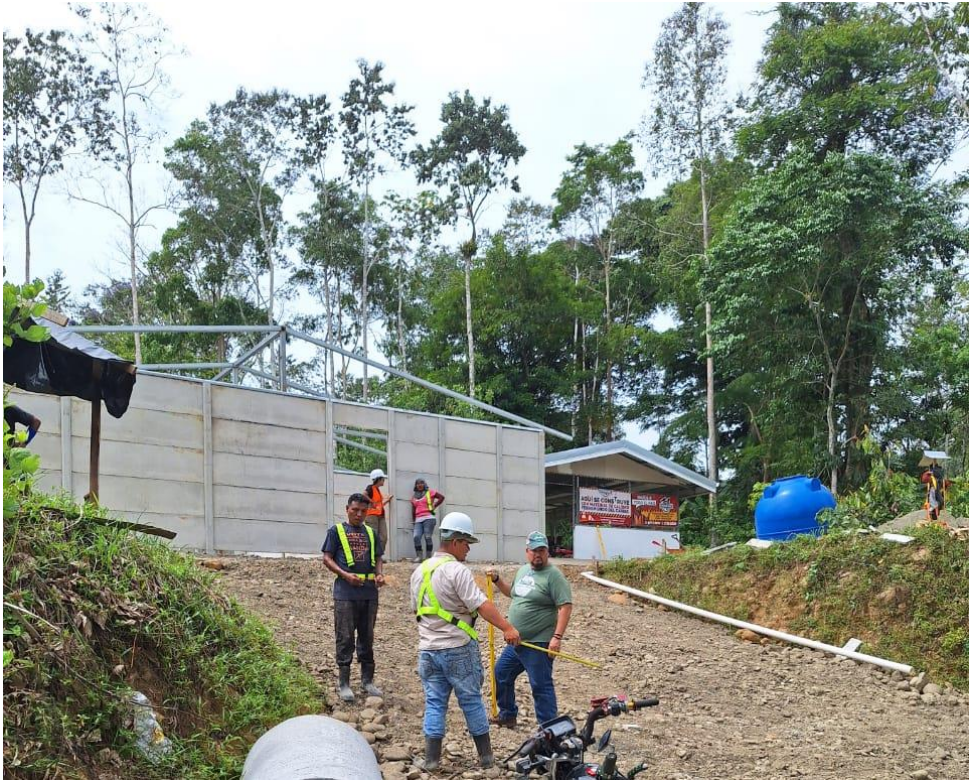
Informe 5. Figura 3. Colocación de capa de lastre en rampa de ingreso
