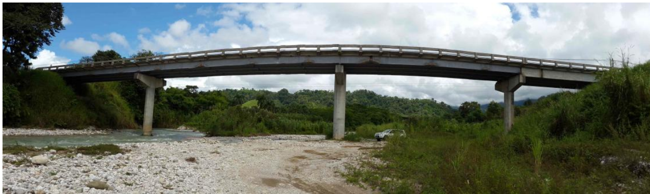
Figura 59. Vista general del puente Río Lagarto.
