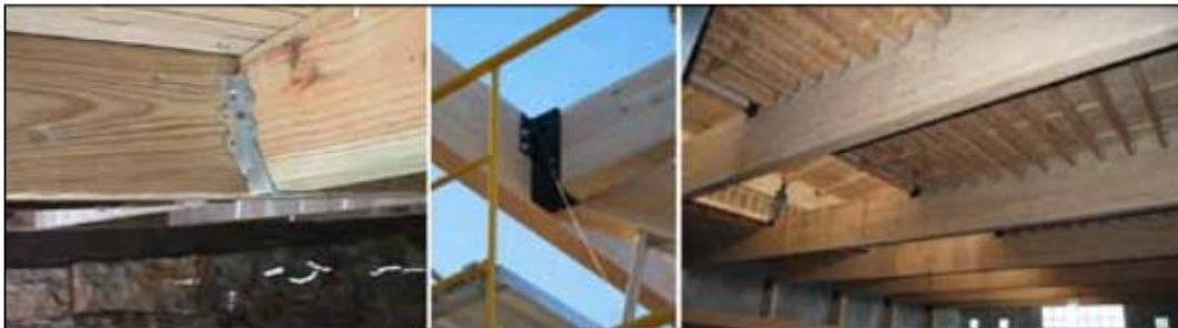
Figura 8. Soportes típicos para viga de madera.
