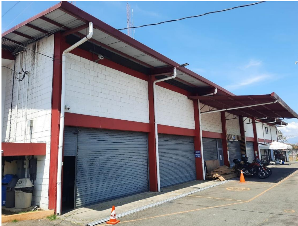
Figura 5. Fachada Externa Bodega DINARE. Fuente: Elaboración propia
